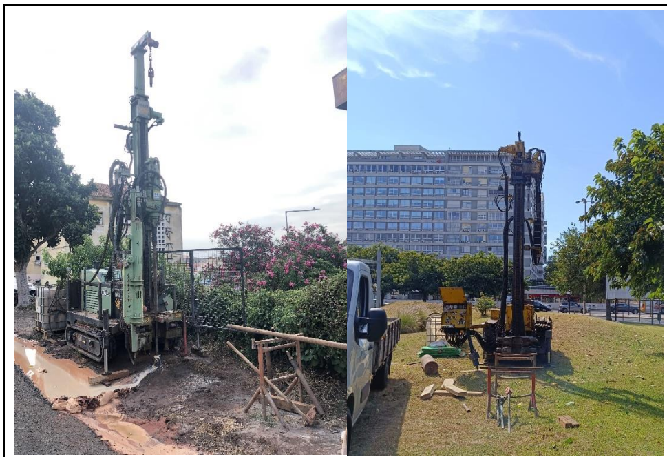
Figura 9 – Aspeto dos equipamentos de furação utilizados
