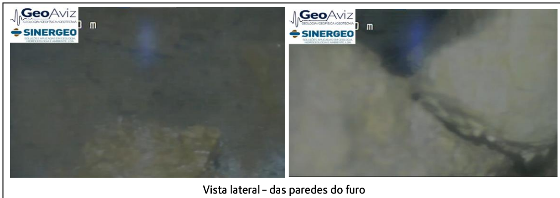
Figura 10 – Fotografias do vídeo na sondagem SG43a aos 17m de profundidade.
