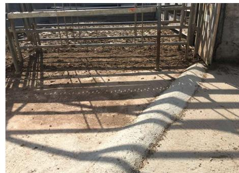
Figura 6 - Rede de drenagem de encaminhamento das águas pluviais do NP4.
