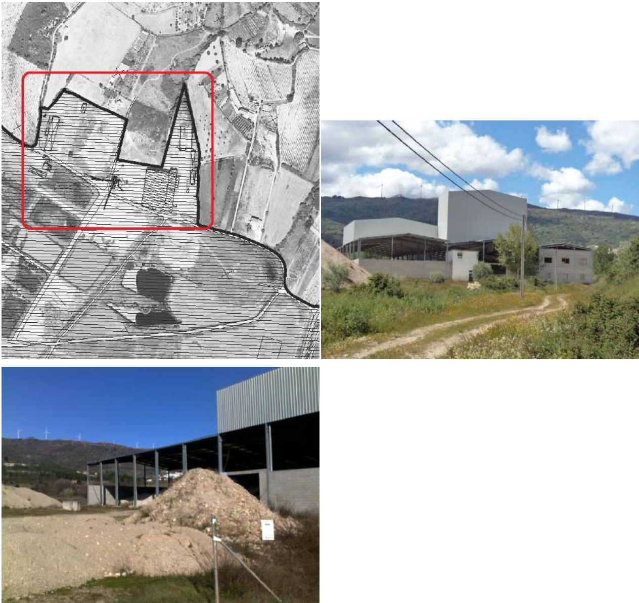
Figura 4.7.1 - Localização da área de apoio de obra e estaleiro e estado atual.
