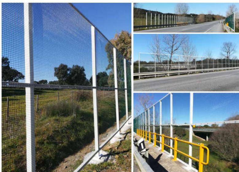
FOTOGRAFIA 1 – BARREIRAS IMPLEMENTADAS NA EN114, NO ÂMBITO DO PROJETO LIFE LINES, COM 3 M DE ALTURA (A PARTIR DA PLATAFORMA), CONSTITUÍDAS POR PRUMOS METÁLICOS DE SECÇÃO RETANGULAR RHS 80X60X3, COM TAMPAS PLÁSTICAS NO TOPO, AFASTADOS DE 2 M, QUE PERMITEM SUPORTAR UMA MALHA DE ARAME GALVANIZADO, SOLDADA E PLASTIFICADA A PVC/POLIÉSTER, COM DIÂMETRO DE 19 X 19 MM E DIÂMETRO DO ARAME DE 2 MM. OS PRUMOS SÃO ENCASTRADOS NO MACIÇO DE FUNDAÇÃO (IP, 2021)
