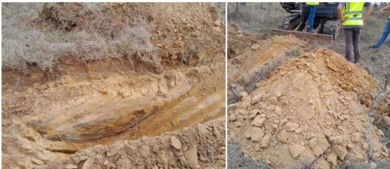
Figura 26 – Aspecto geral do poço P7
