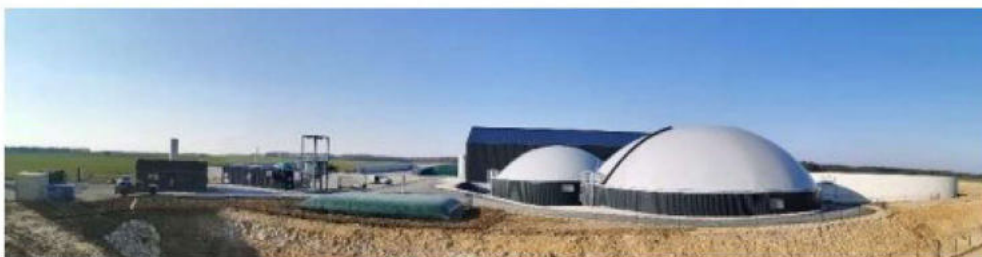
Exemplo de digestores
