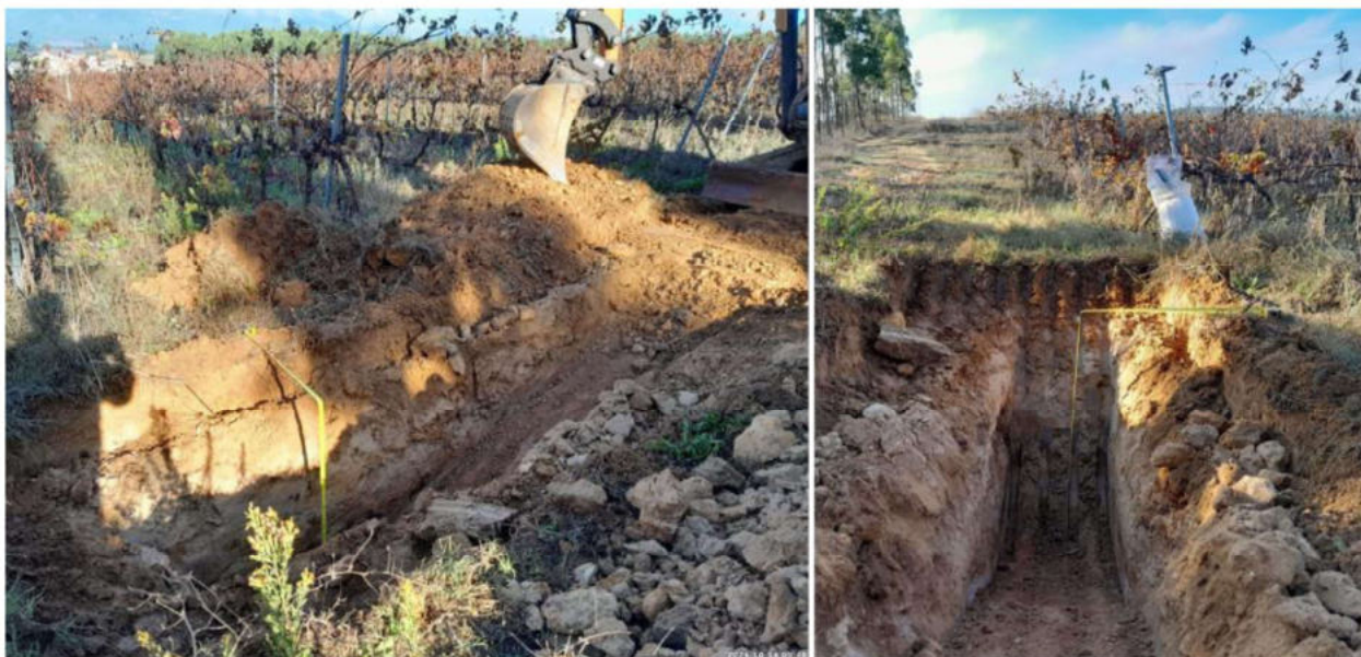
Figura 25 - Aspeto geral do poço P3
