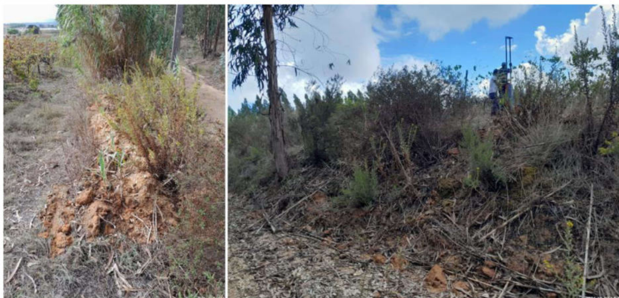
Figura 20 – Trecho onde o limite da propriedade aparenta estar em aterro.
