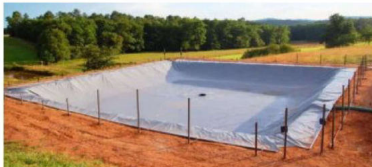
Exemplo de lagoa coberta-digerido
