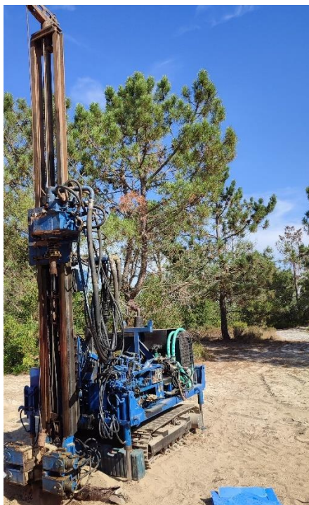
Figura 14 Equipamento de sondagens geoambientais utilizada em obra
