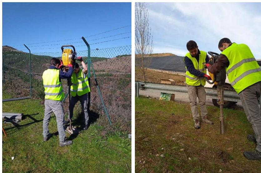
Figura 6 – Fotos ilustrativas do decorrer dos trabalhos executados.
