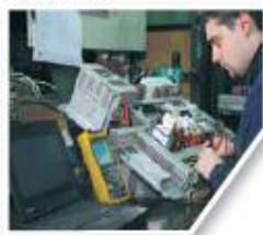
Cableado de cuadro eléctrico Control panel wiring
