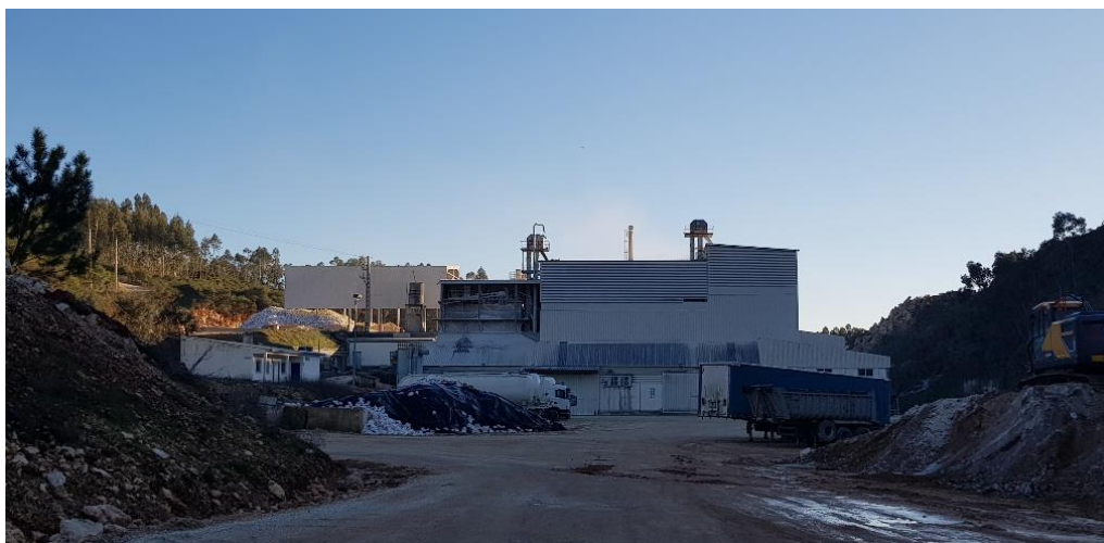
Figura 3 – Aspecto actual da área de implantação da unidade industrial na área de pedreira a licenciar.
