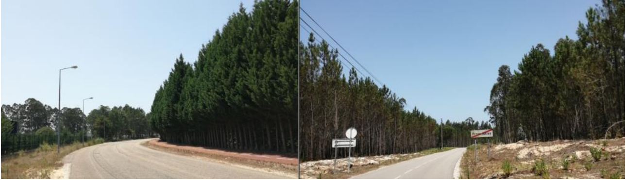
Figura 27 - Obstrução visual associada à presença de vegetação (norte de Cantanhede à esquerda / saída de Franciscas à direita).
