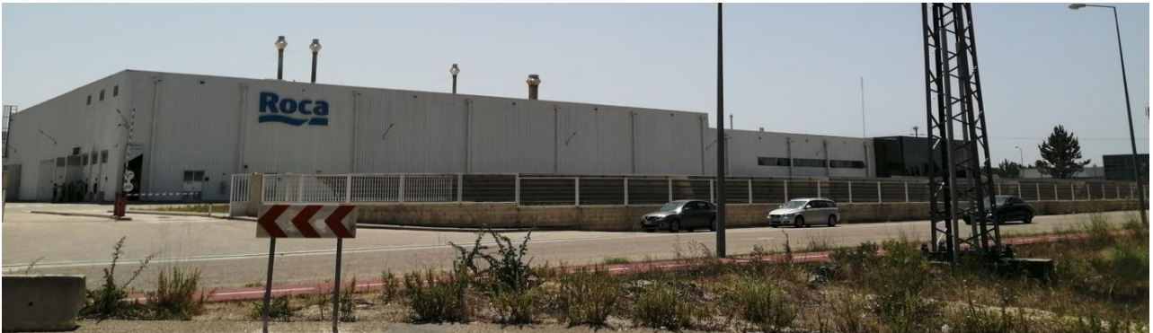
Figura 22 - Perspetiva obtida a partir de noroeste sob a unidade industrial da Roca SA.
