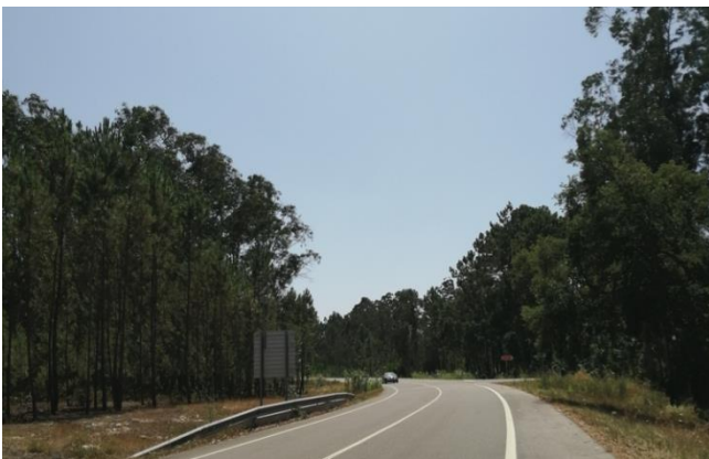
Figura 29 - Obstrução visual associada à presença de vegetação ao longo da M583 a sul de Coutada.
