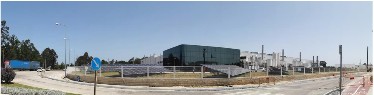
Figura 23 - Panorâmica obtida a partir de oeste sob a unidade industrial da Roca SA.
