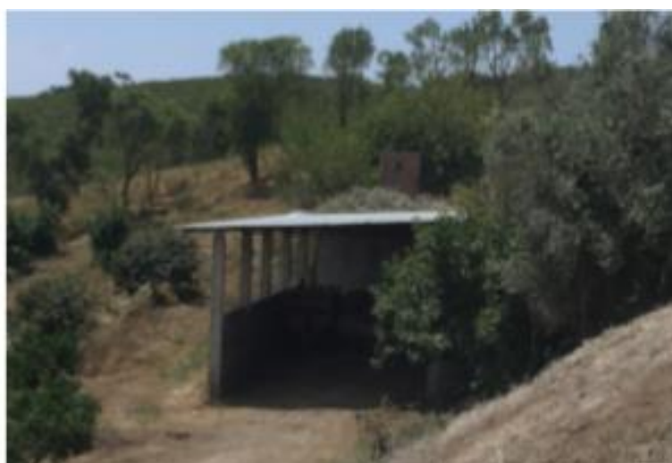
Figura 6: Armazém de estrume no núcleo de Sarruadas
