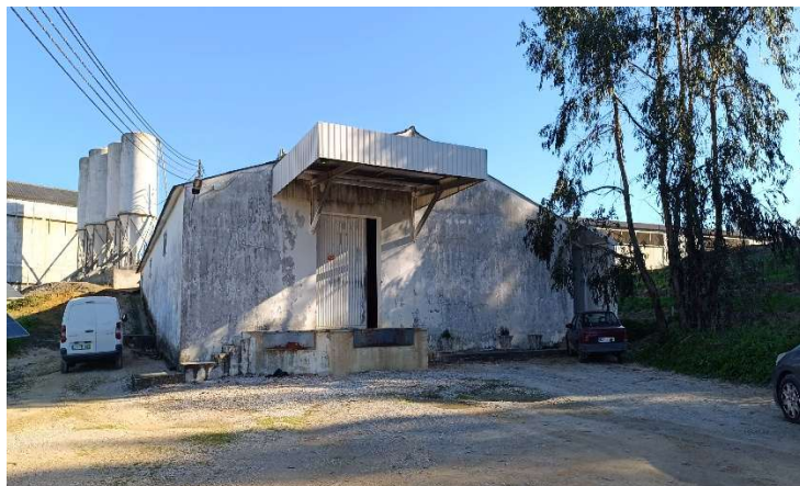
Figura 6.2 – Vista para o ARO1
