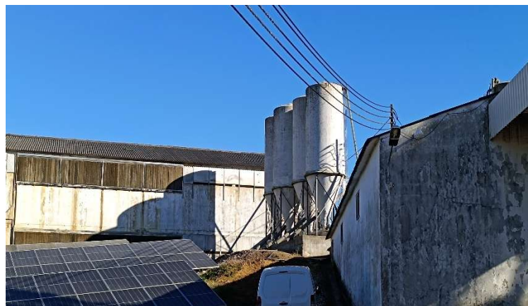
Figura 6.4 - Vista dos Silos
