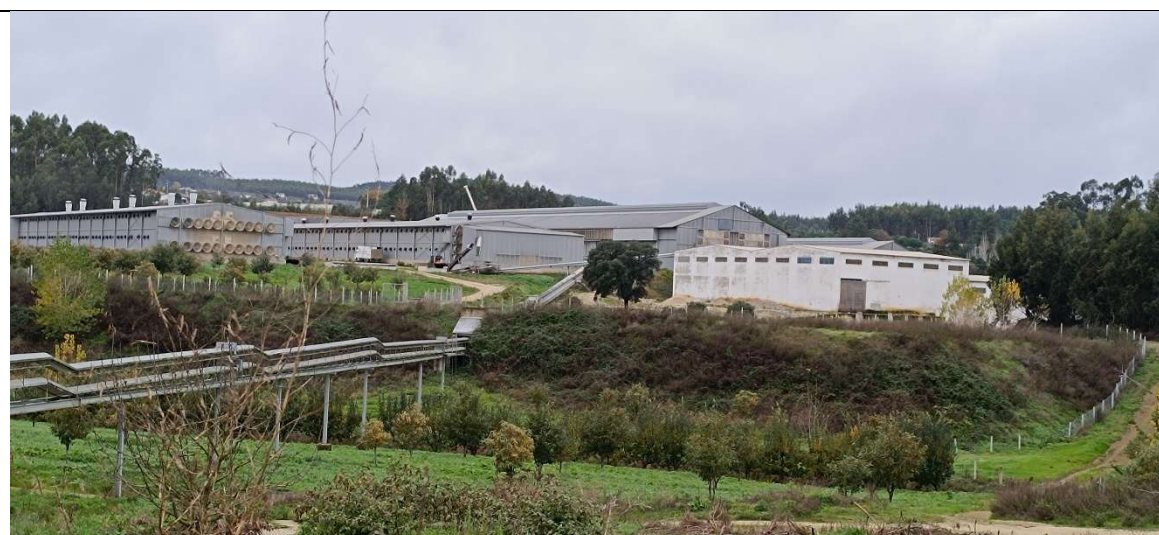
Figura 7.30 – Vistas de outras áreas de usos industriais (instalação avícola da Cabrala) localizados na proximidade da instalação avícola em estudo.
