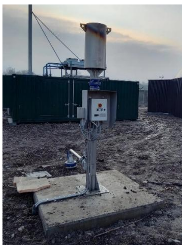
Figura 39. Exemplo de uma tocha para volumes reduzidos ( <100 \text{ Nm}^3/\text{h} ).
