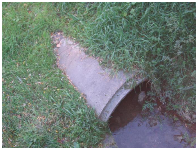
Figura 1 – Ponto de descarga EH2
