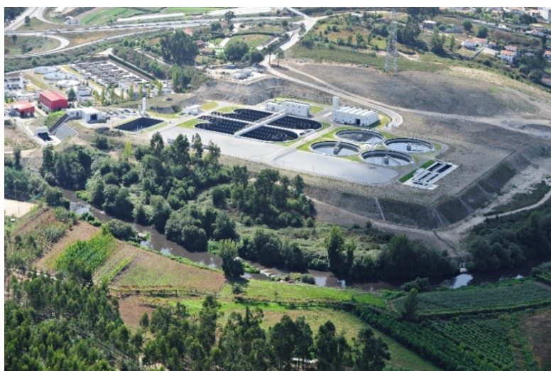
Figura 2.3 – Vista aérea (2) para a ETAR de Serzedelo e local de implantação da Unidade Centralizada de Tratamento de Lamas
