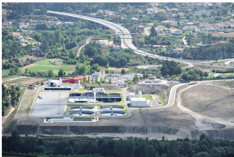
Figura 2.2 – Vista aérea (1) para a ETAR de Serzedelo e local de implantação da Unidade Centralizada de Tratamento de Lamas
