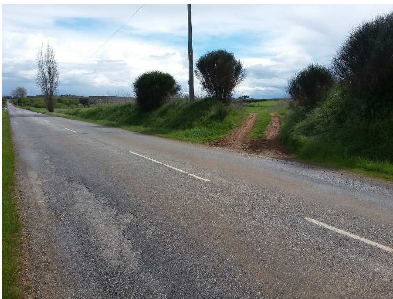
Figura 5.3 – Local de atravessamento da ER381 pela CAG-T3, ao km 7+044.
