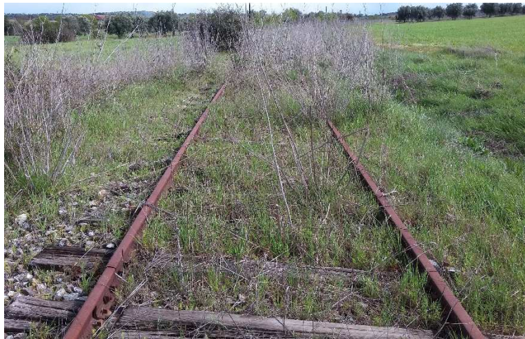
Figura 5.4 – Local de atravessamento da linha ferroviária pela CAG-T3.
