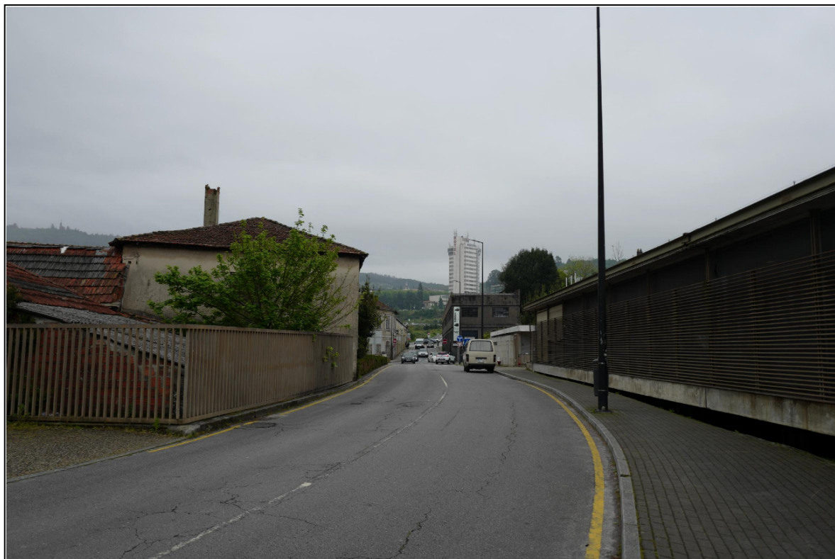
Figura 5.2 - Vista atual sobre a área do projeto, a partir do Mercado Municipal de Guimarães.
