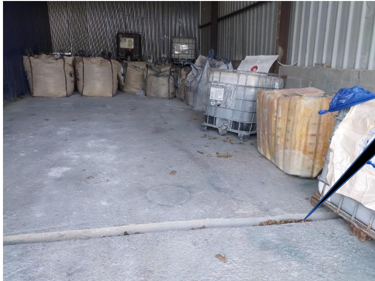
Figura 7 – Caleira de Recolha de derrames depósito Lamas
