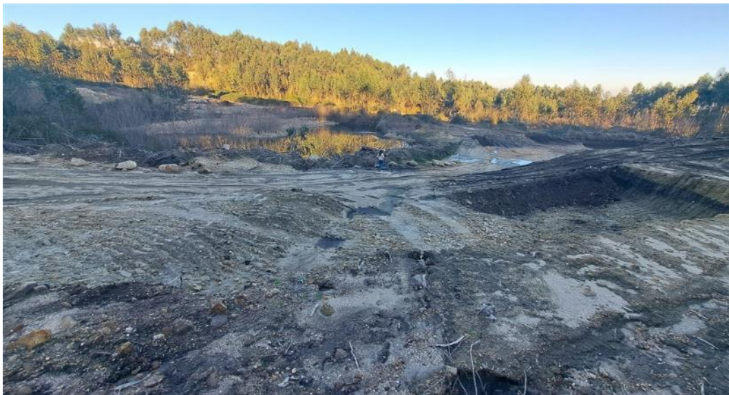
Figura 148 - Vista geral da área do projeto, vista de oeste para este, desaterrada.
