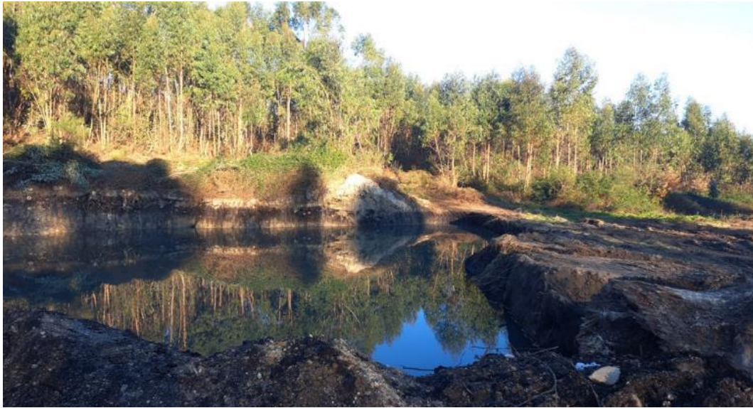
Figura 151 - Vista geral da área do projeto, ao centro, desaterrada.
