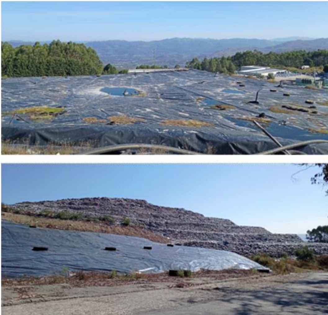
Figura 155 - Panorâmica em cima (a norte) e em baixo (a sul) do local destinado à reengenharia do aterro.
