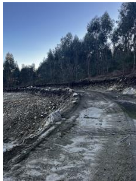
Figura 130 – Área destinada à célula de ampliação ao aterro apresentando áreas verdes (A), áreas de solo exposto (B), charca de águas (C) e vias de circulação (D).
