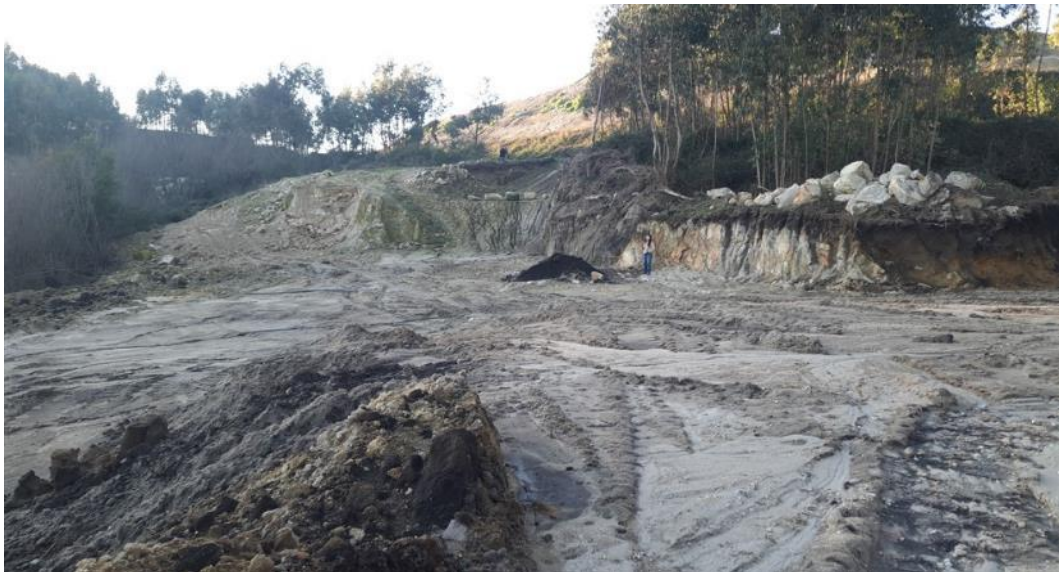
Figura 152 - Vista geral da área do projeto, de sul para norte – desaterrada.
