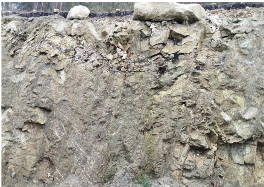
Figura 28 – Observação de talude rochoso granítico, medianamente alterado W3 a muito alterado W4 e muito fraturado F4, com evidência de movimentos de dobramento e preenchimento argiloso: estação geológica #4.
