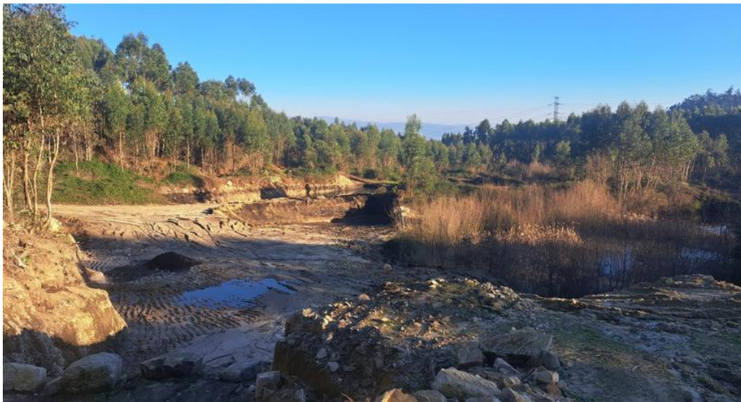
Figura 145 - Vista da área do projeto, de norte para sul, desaterrada.
