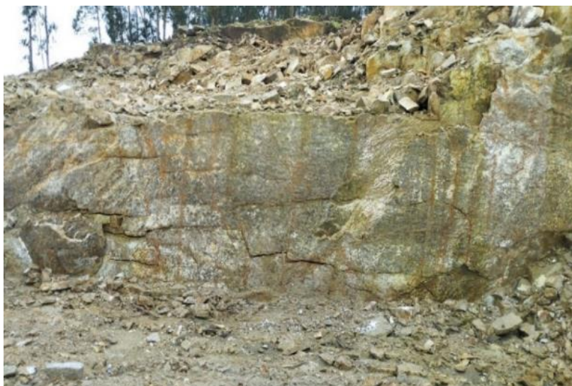
Figura 26 – Observação das principais famílias de diáclases com fraturação F4-F3 e grau de alteração W4-W3, presentes no substrato rochoso do talude a noroeste da área: estação geológica #2.
