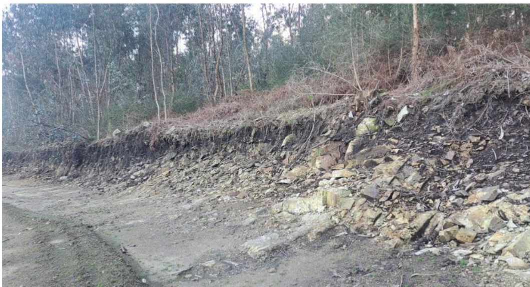
Figura 146 - Extremo oeste da área do projeto - talude dos desaterros.
