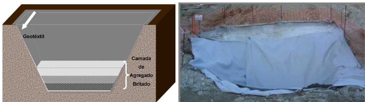
Figura 18 - Representação esquemática do perfil (esq.) e exemplo de vala de lavagem de caleiras (dir.).
