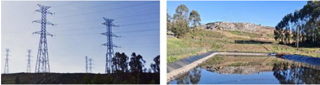
Figura 215 – Estruturas de transporte de eletricidade (esq.) e aterro e lagoa de lixiviados (dta.).
