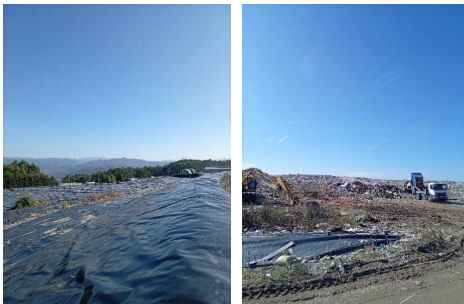
Figura 201 – Fotografias da área de reengenharia – zona norte, célula 1 (esq.); zona central, topo do aterro (dta).
