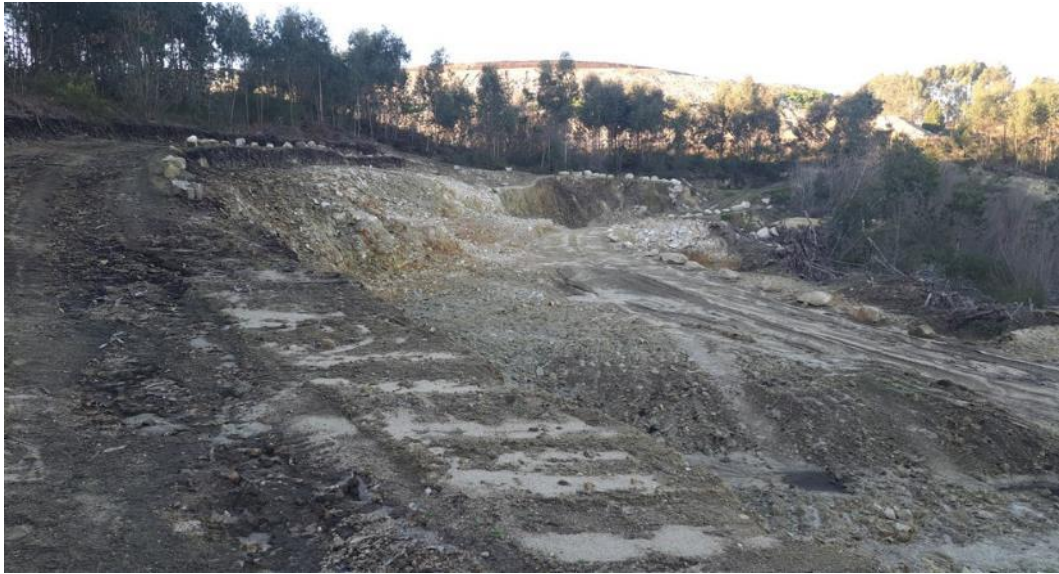
Figura 149 - Vista geral da área do projeto, de sul para norte, desaterrada.
