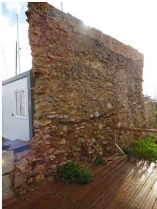
Figura 67 – Parede Oeste (parede original) do Moinho do Sobradinho com revestimento em cimento e ferro.
