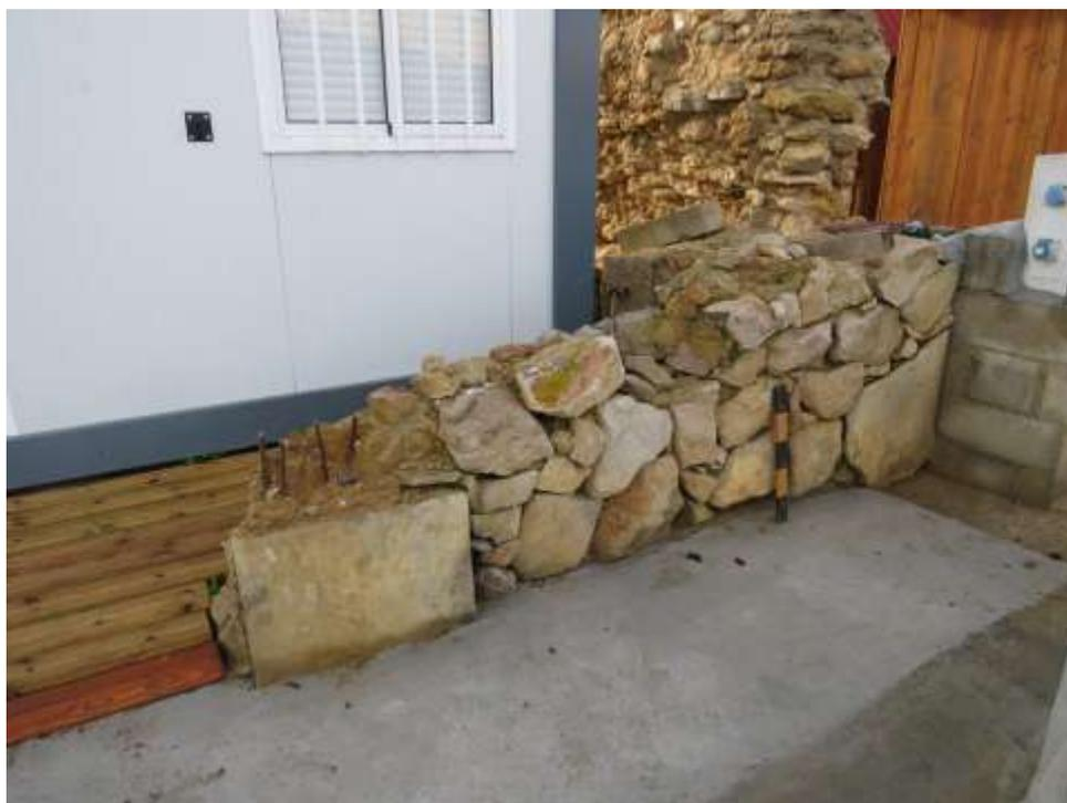
Figura 66 – Exemplo de um dos muros do Moinho do Sobradinho, reconstruído com pedra, cimento e ferro.
