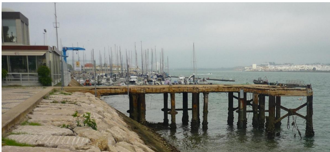
FIG. 68 - Cais em estacada em ruína a demolir
