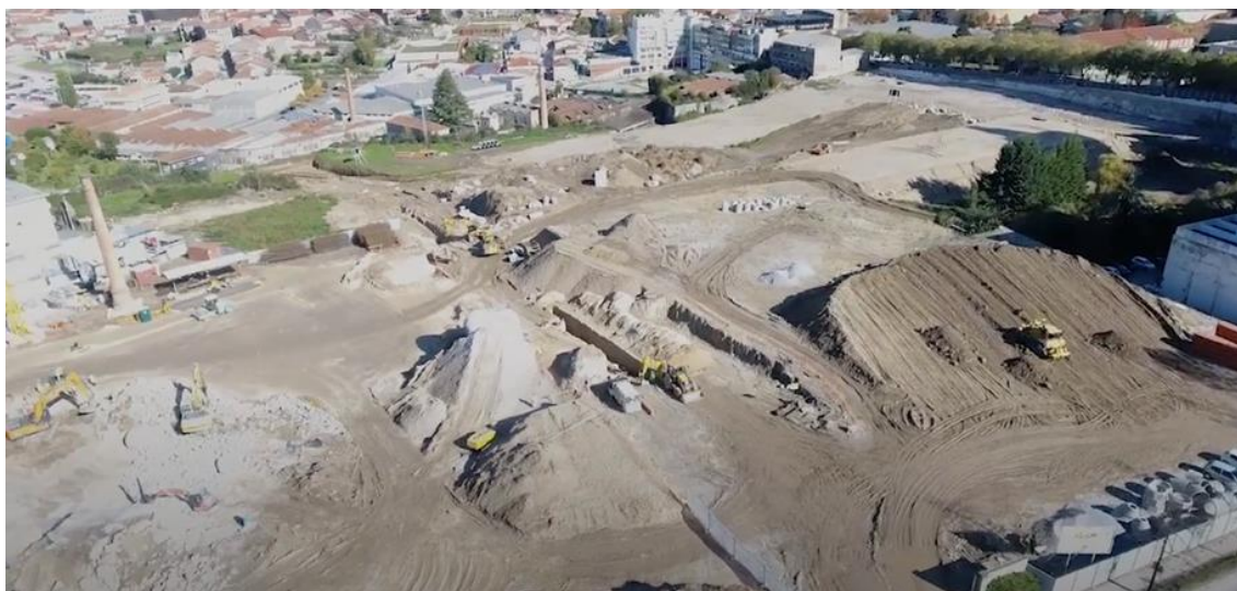
Figura 157 Vista do loteamento durante as terraplanagens e colocação de infraestruturas no mês de novembro de 2020. Guimarães Digital.
