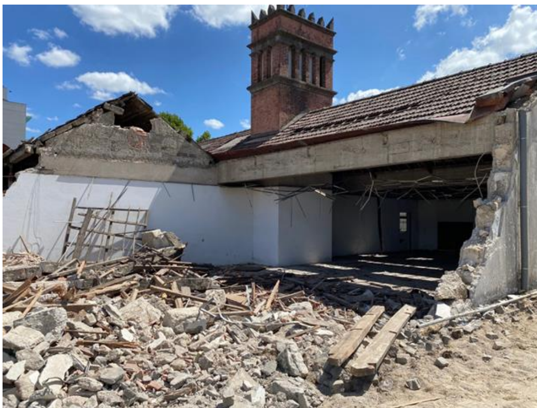
Figura 110 Fábrica do Minhoto durante as demolições. Ano de 2020.
