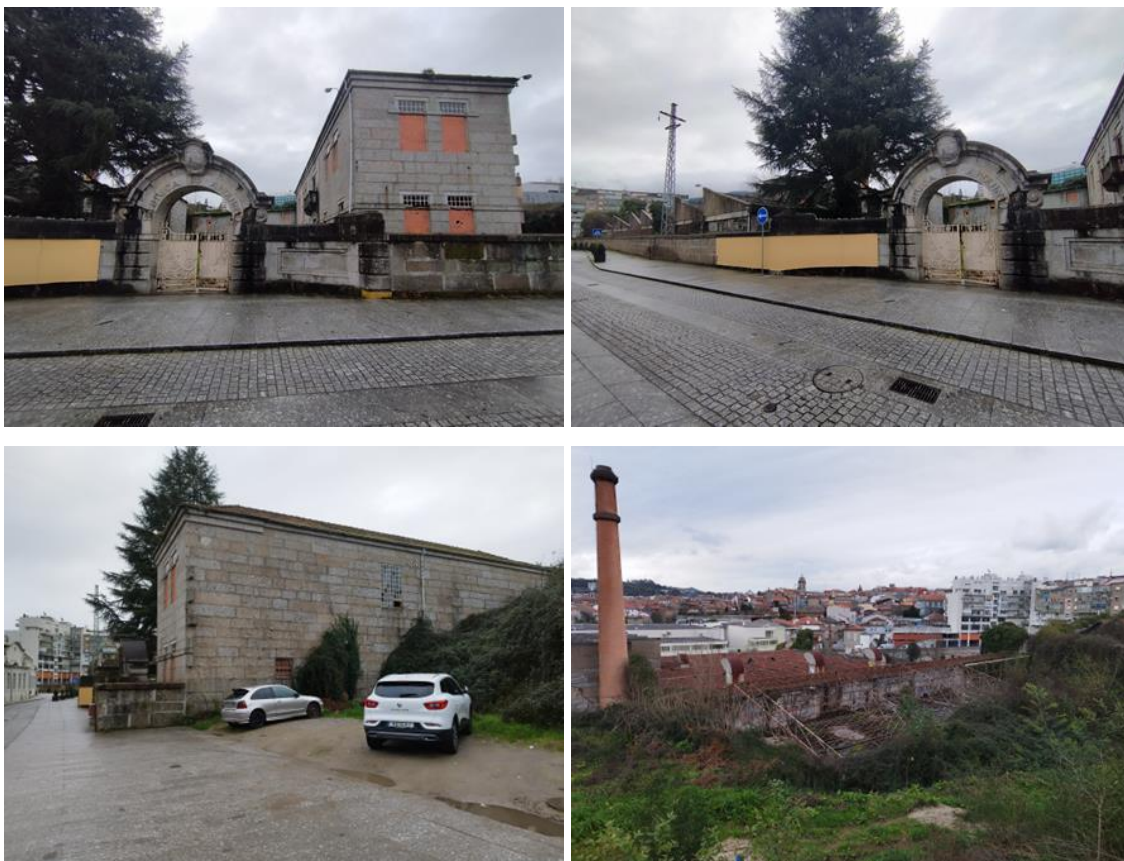
Figura 138 Fachada da fábrica voltada para a rua da Caldeirôa e fachada lateral, nave central com as tesouras metálicas à vista e a chaminé como elemento vertical de destaque, respetivamente.
