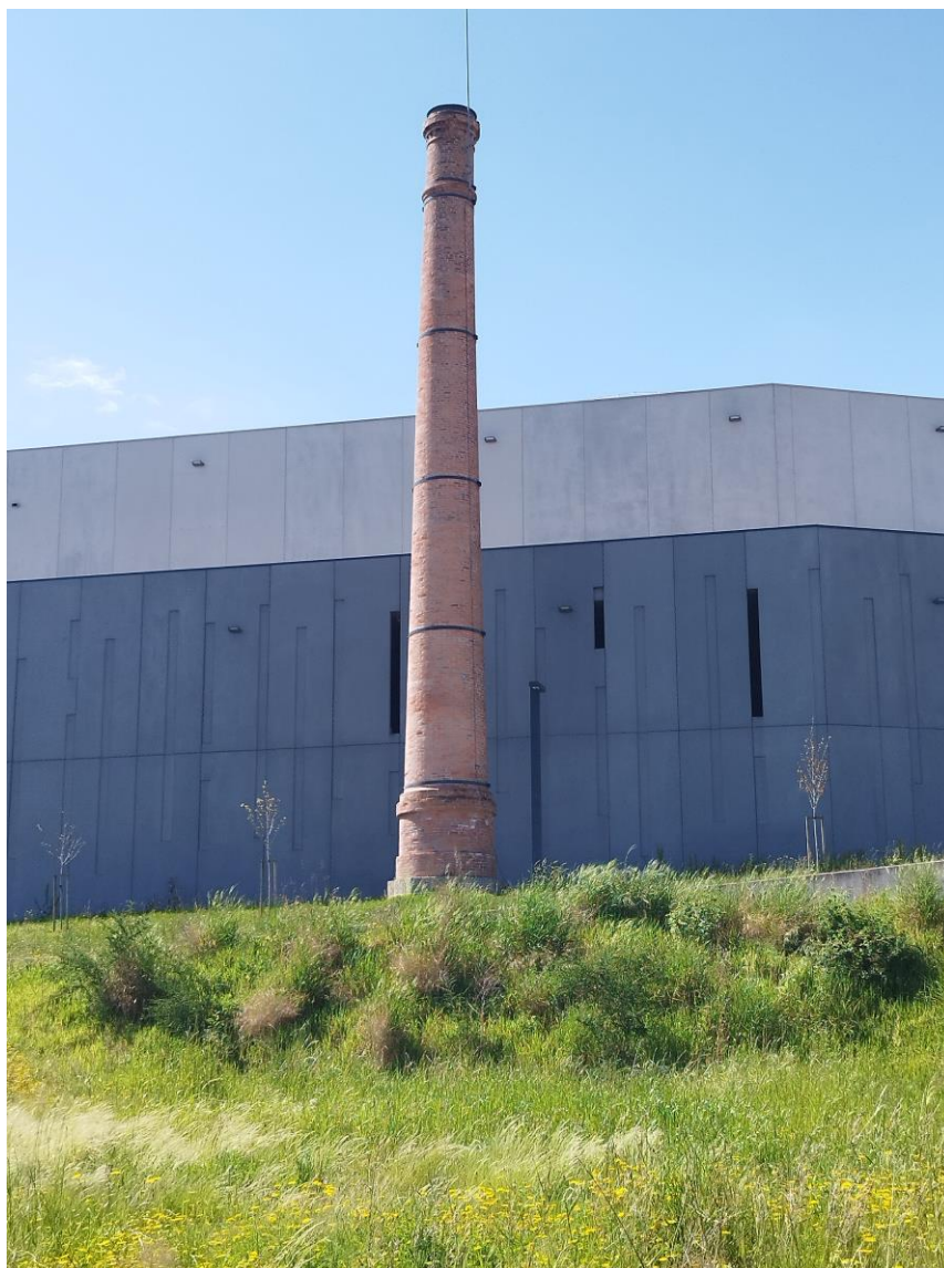
Figura 135 Chaminé da Fábrica da Jodimonte preservada junto ao Supermercado Mercadona. 2025.
