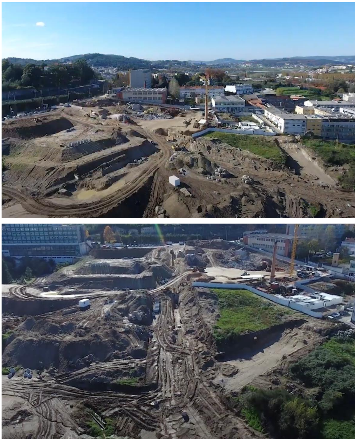
Figura 158 Vistas do loteamento durante as terraplanagens e colocação de infraestruturas no mês de novembro de 2020. Guimarães Digital.
