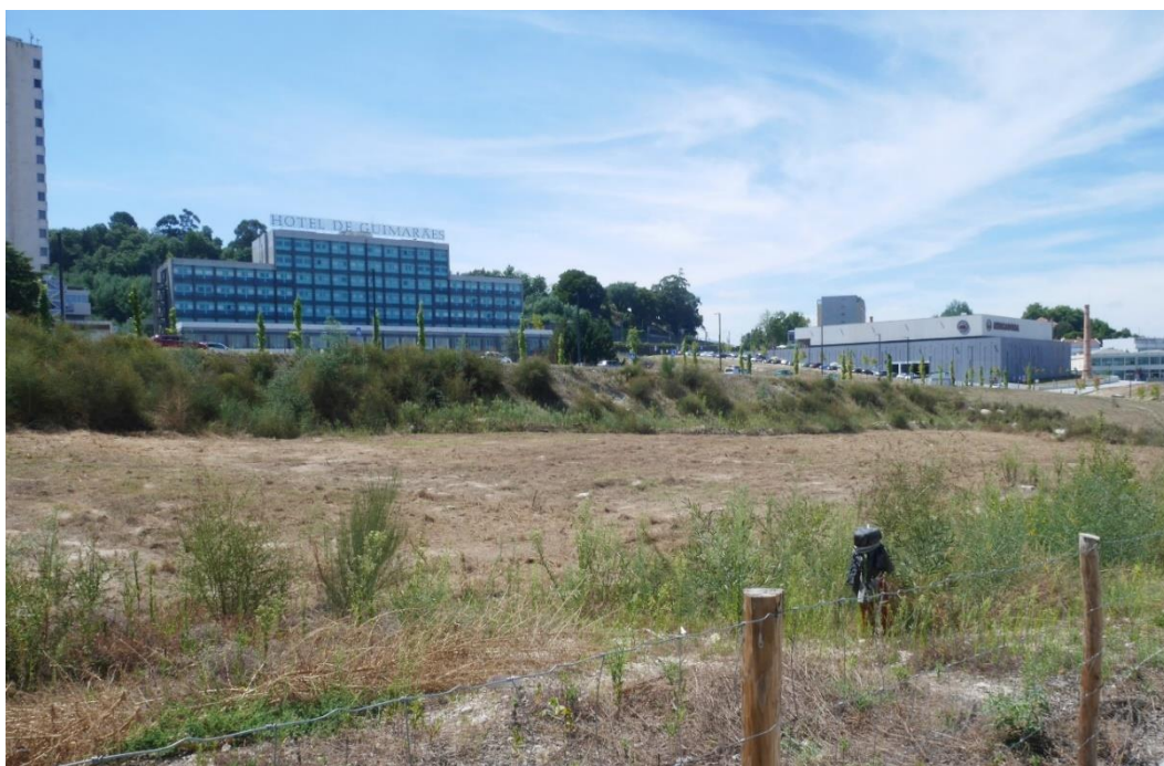
Figura 15 Fotografia da vista sobre talude de escavação revestido por vegetação.
