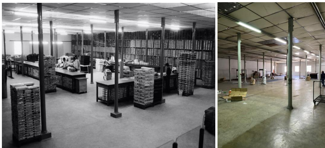
Figura 108 Interior da Fábrica alguns anos 60 do séc. XX., espaço antes das demolições, sendo visíveis a estrutura em colunas de ferro de suporte da cobertura, respetivamente.
