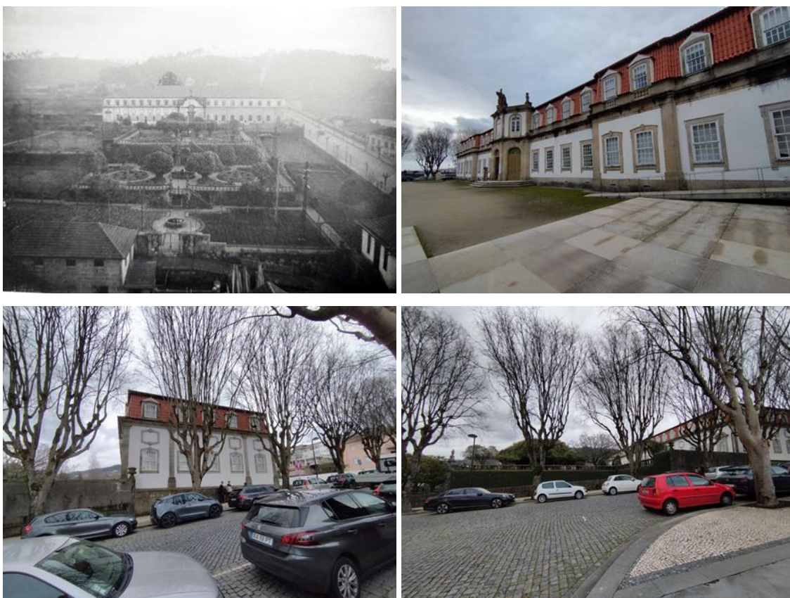
Figura 136 Vista da Fachada Norte do Palácio Vila Flor nos anos de 1950 e da Avenida de Cândido Reis com a Fábrica do Cavalinho. (PTRMGMRFCM0412), Fachada Sul, fachada Oeste e jardim do Palácio de Vila Flor na atualidade, respetivamente.
