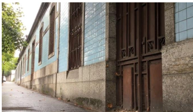
Figura 107 Fachada principal da Fábrica do Minhoto no ano de 2020.
