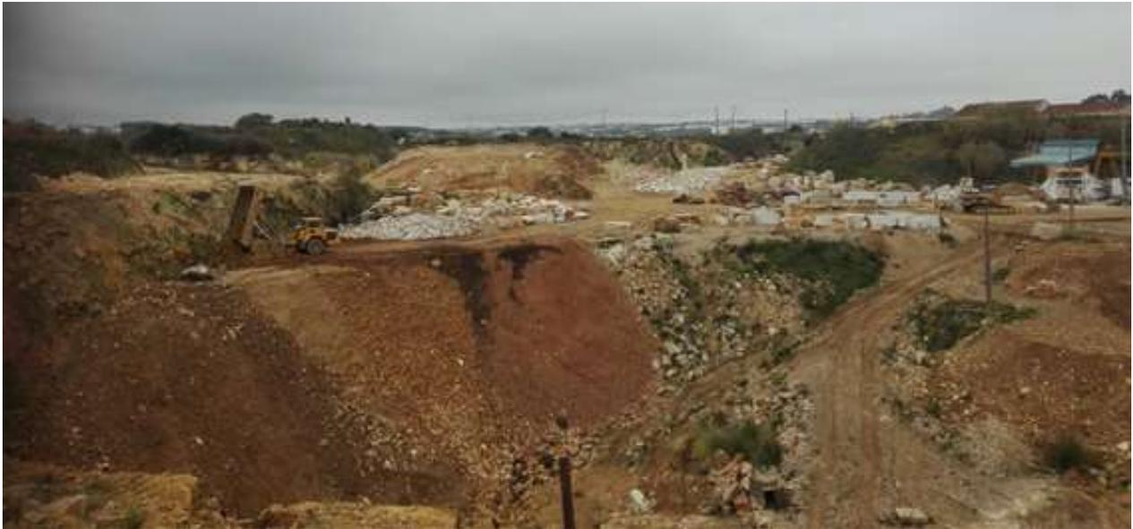
Fotografia 1 – Aterro a realizar para manutenção da superfície de desobstrução aeronautica
