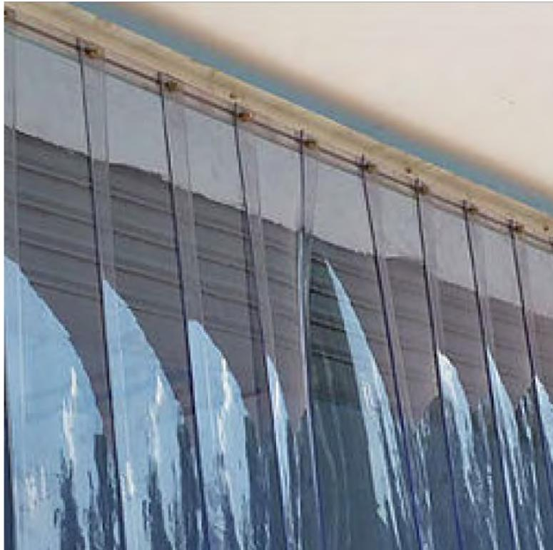
Figura 28: Ilustração da implementação de tiras PVC em fachada para aumento do seu isolamento sonoro
