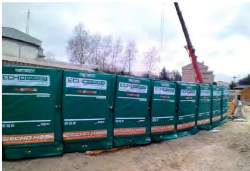
Figura 25: Exemplo de barreira acústica fixa desenhada especificamente para resistir às condições de obra
