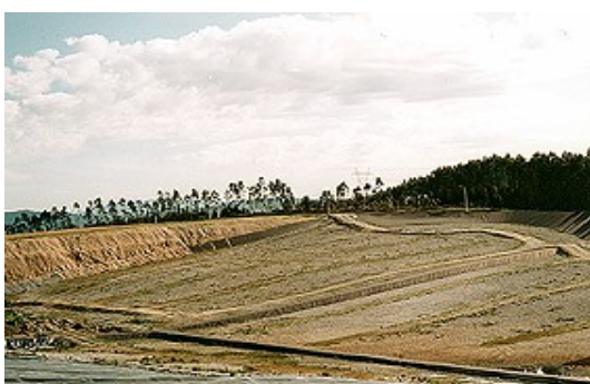
Figura 3: Frente de trabalho compactada e com cobertura de terras. (Fonte: BRAVAL)
