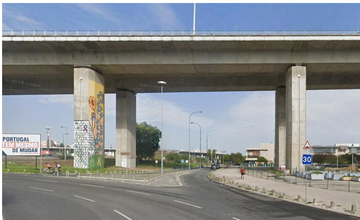
Figura 5.41 – Viaduto norte da Ponte Vasco da Gama / Via do Oriente
