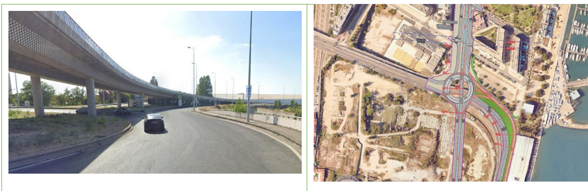
Figura 5.38 – Viaduto da Av. Marechal Gomes da Costa
