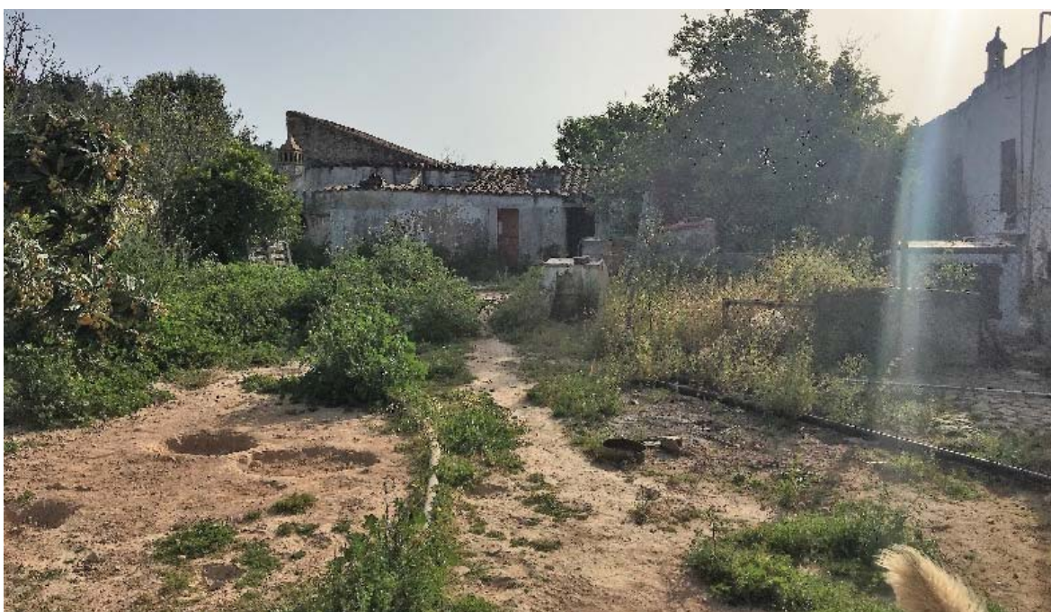
Figura 5 – Vista do local (na área de implantação do Bloco A).
