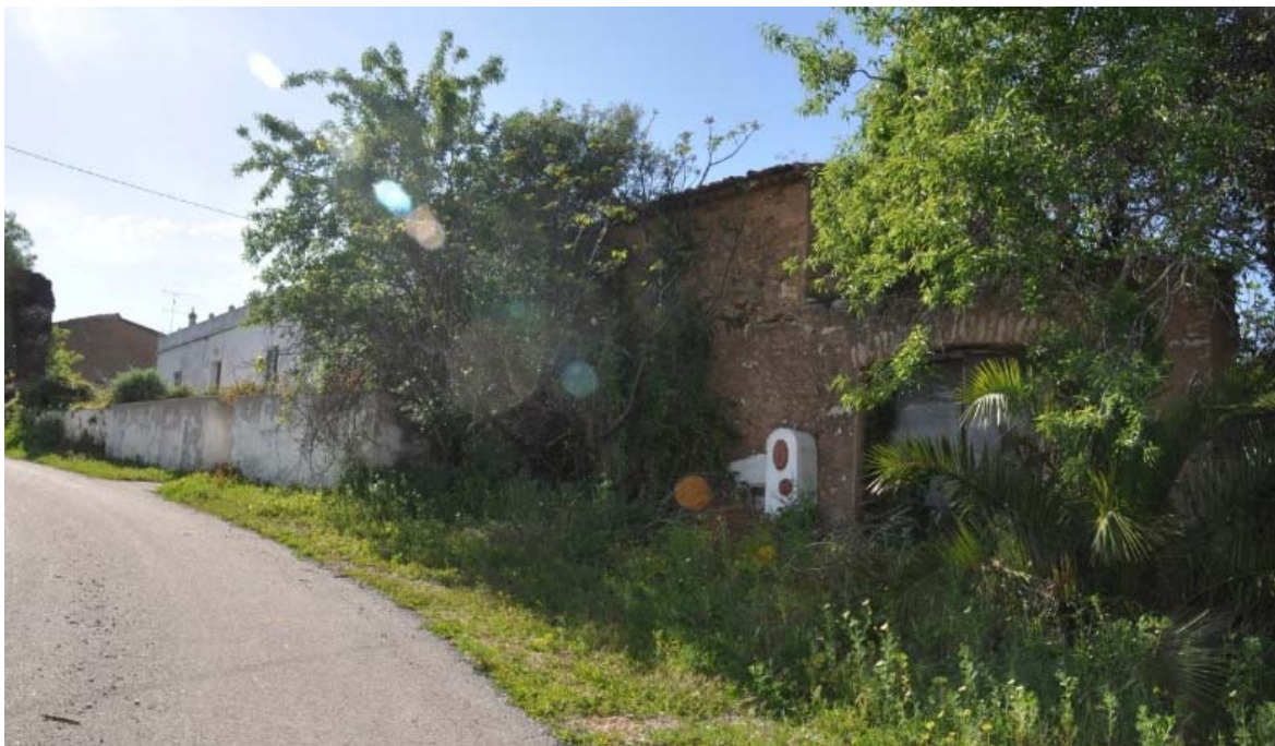
Figura 2 – Vista do local de intervenção a Nascente (na área de implantação do Bloco A).
