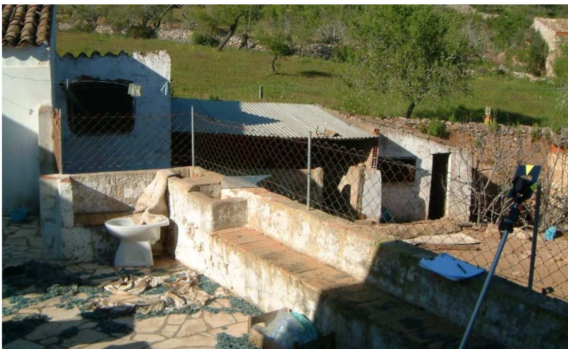
Figura 4 – Vista do local de intervenção (na área de implantação do Bloco A).
