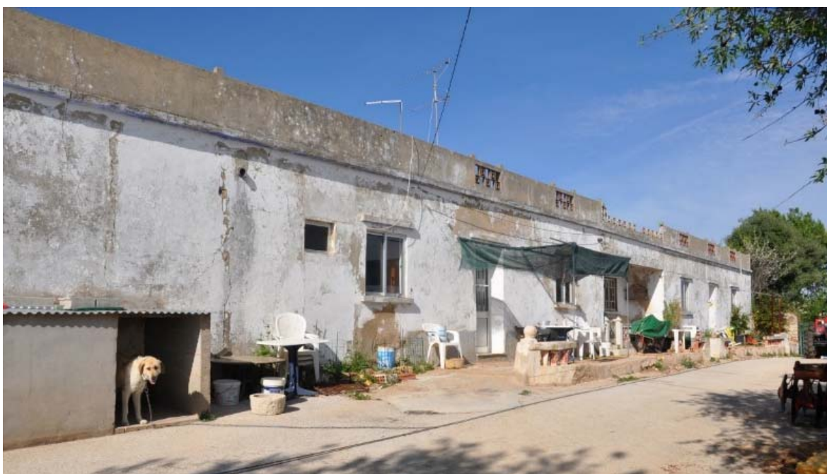
Figura 3 – Vista do local de intervenção (na área de implantação do Bloco A).
