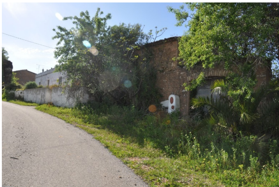
Figura 7 – Vista a Nascente, a partir do acesso que estabelece a ligação ao caminho de S. Vicente.
