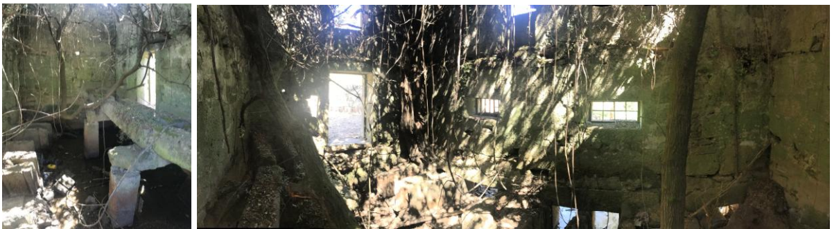
Foto 8.5 – Aspeto da azenha da Ponte de Moinhos.
