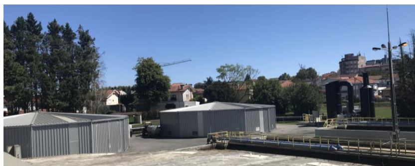
Observador localizado no topo de um edifício existente na ETAR e voltado para Este
