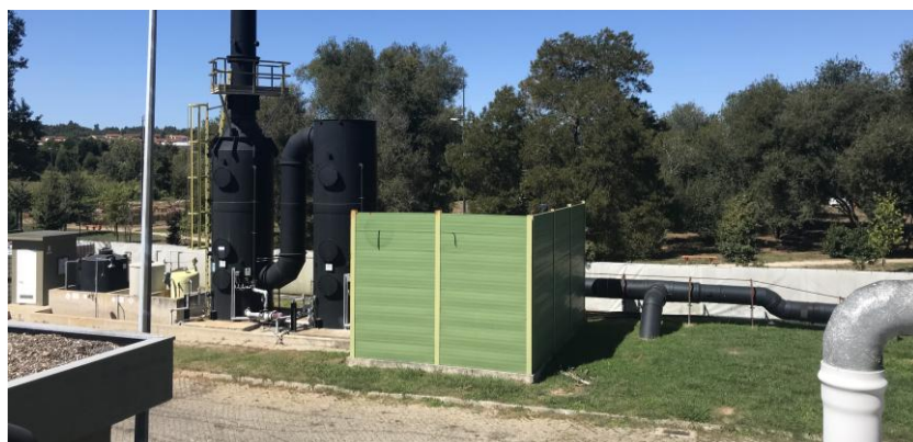
Observador localizado no topo de um edifício existente na ETAR e voltado para Norte
