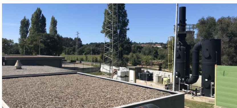
Observador localizado no topo de um edifício existente na ETAR e voltado para Oeste
