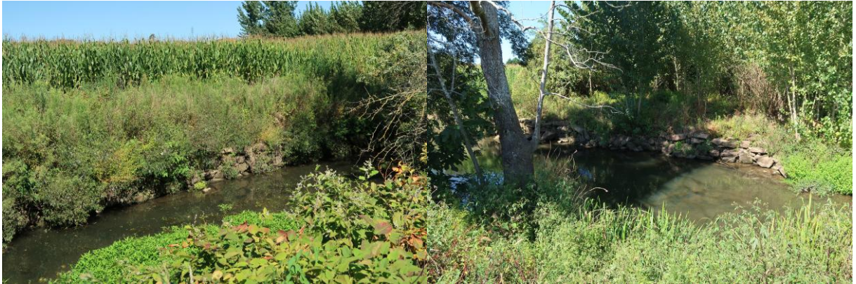
Foto 8.4 – Muros de pedra e margens encanadas do rio Leça.
