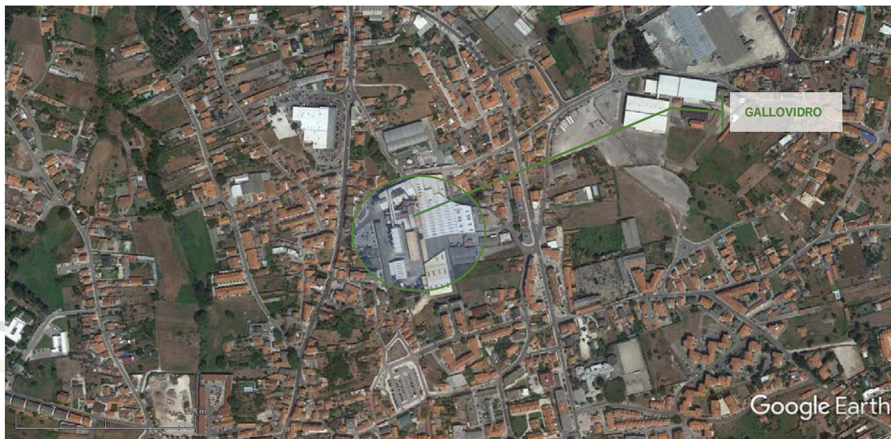
Figura 1 - Localização das instalações da GALLOVIDRO (fonte: GoogleEarth)
