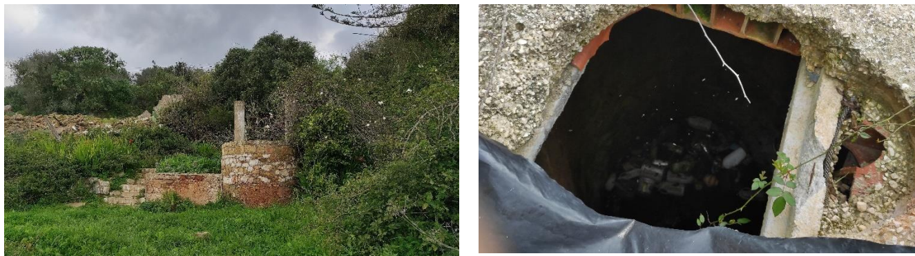
Figura 4.8 – Imagem de conjunto (esquerda) e de pormenor (direita) do poço identificado no terreno a oeste da área afeta ao Loteamento de José Eurico Calado
