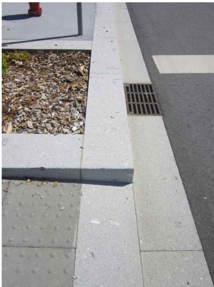
Figura 17 Fotografia de pormenor da rede de pluviais executada.
