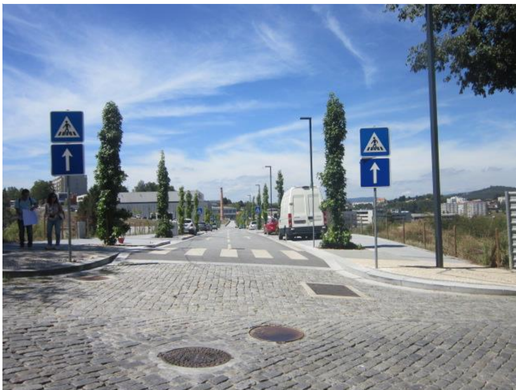
Figura 20 Fotografia da Rua da Indústria executada, a partir da Av. D. Afonso Henriques.
