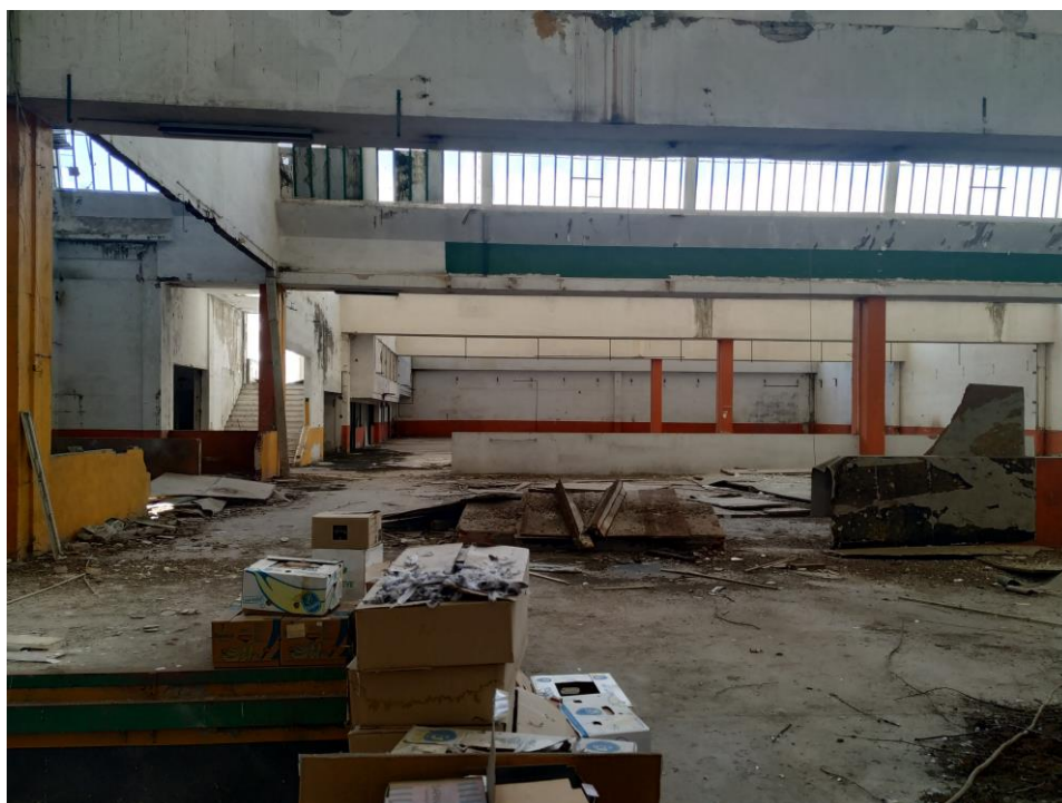
Fotografia 32 – Vista interior de um Hangar – Piso térreo
