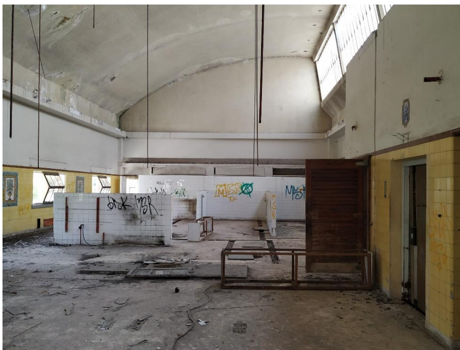
Fotografia 25 – Vista interior do edifício administrativo – Edifício I
