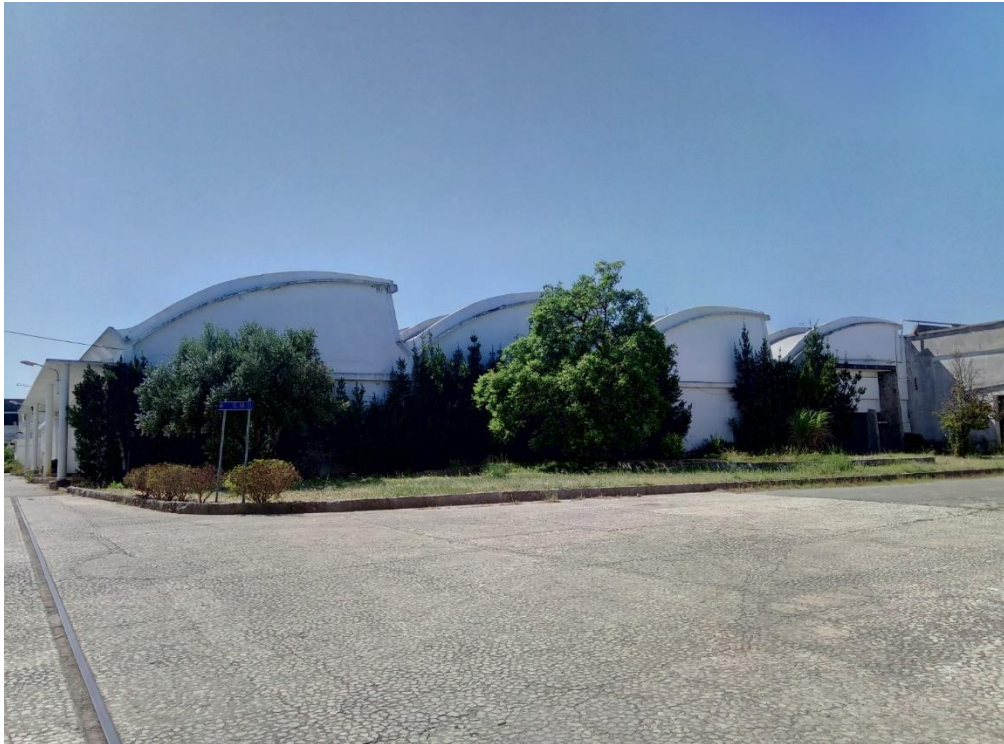
Fotografia 29 - Vista exterior dos hangares
