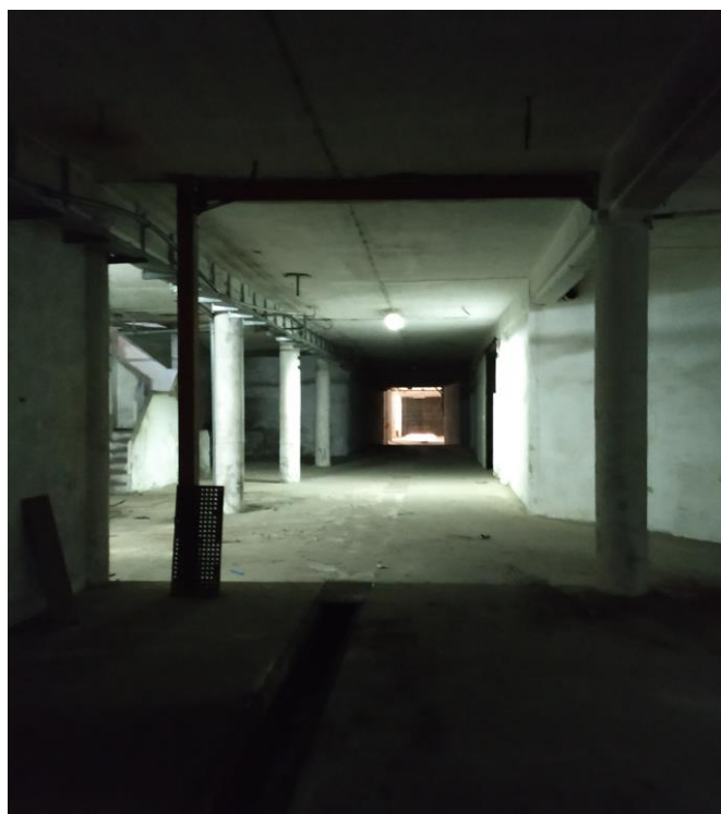
Fotografia 35 – Vista interior de um Hangar – Piso semienterrado
