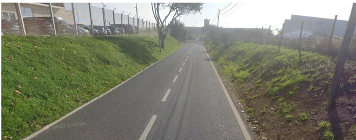
Figura 19 – Secção da Estrada da Medrosa (Fonte: Google Earth).
