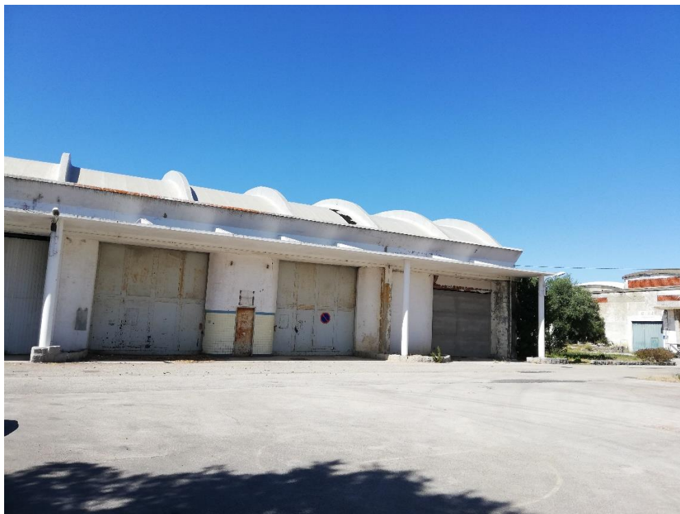
Fotografia 31 – Vista exterior dos hangares
