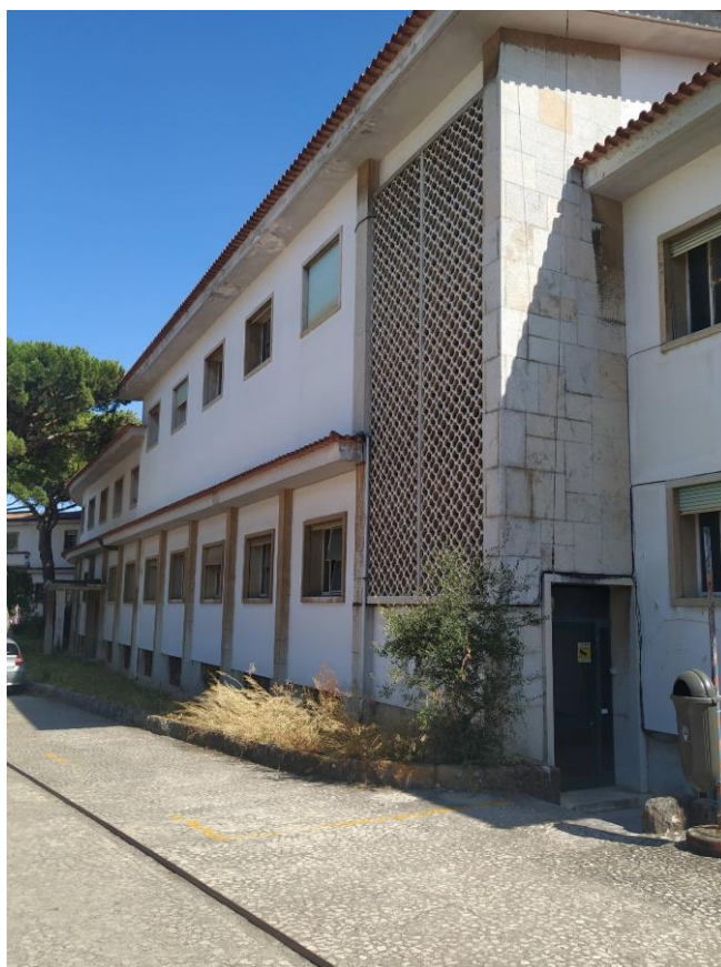
Fotografia 23 – Vista exterior do edifício administrativo – Edifício J
