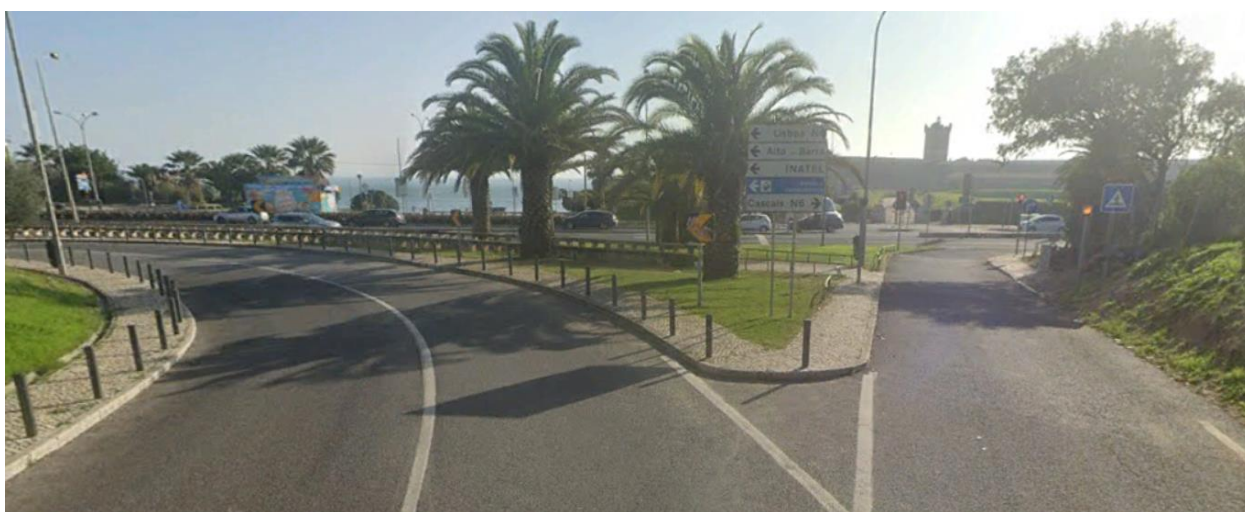
Figura 20 – Futura interseção entre a Estrada da Medrosa e a Estrada Marginal (Fonte: Google Earth).
