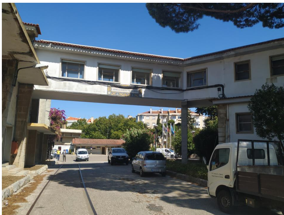
Fotografia 22 – Entrada principal da Fábrica (Edifício J)
