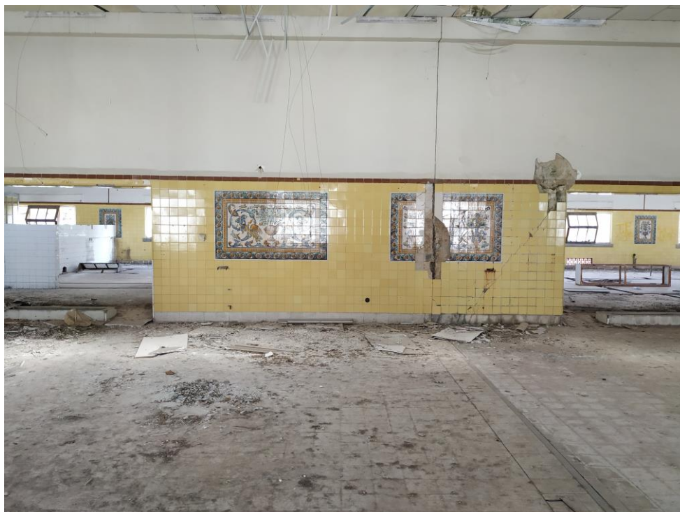
Fotografia 27 – Vista interior do edifício administrativo – Edifício I
