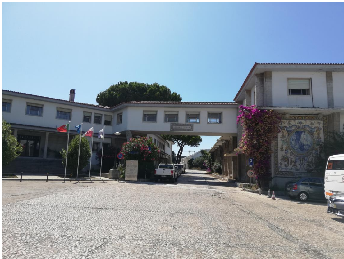
Fotografia 21 – Entrada principal da Fundação (Edifício J)
