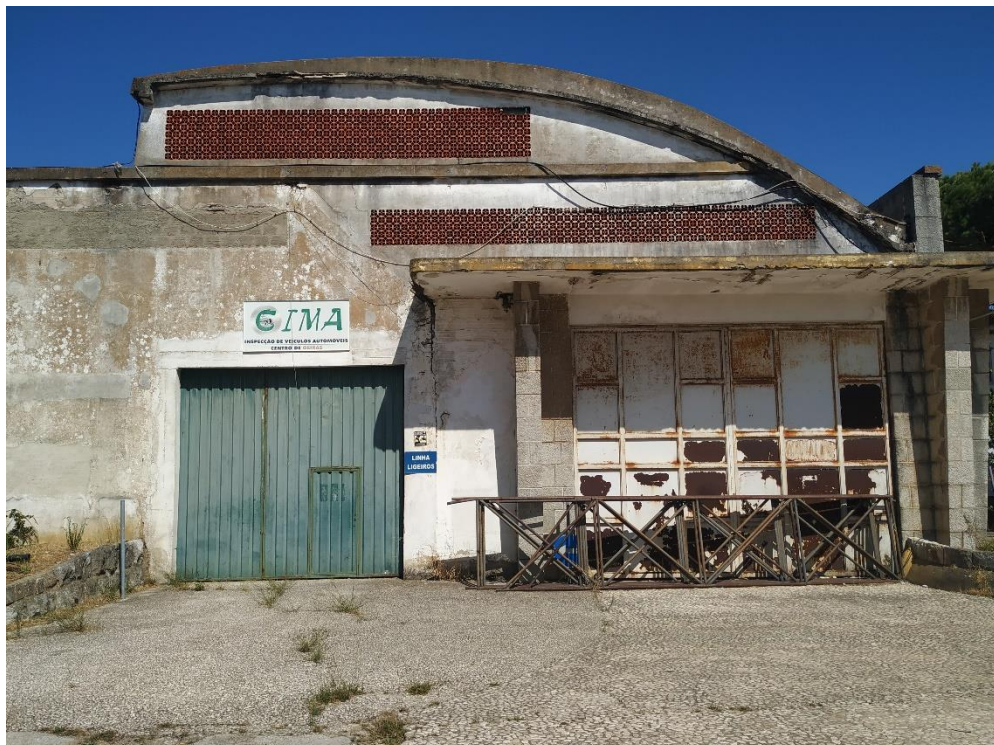
Fotografia 30 - Vista exterior dos hangares
