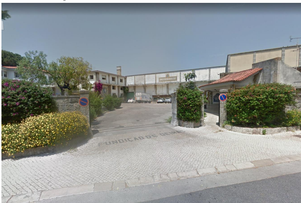
Vista atual da entrada principal da Fundição de Oeiras, do lado nascente do complexo industrial
