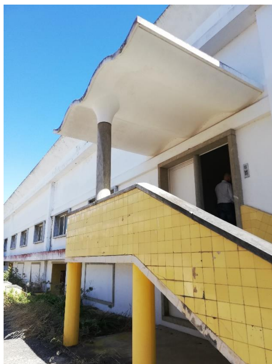
Fotografia 24 – Vista exterior do edifício administrativo – Edifício I
