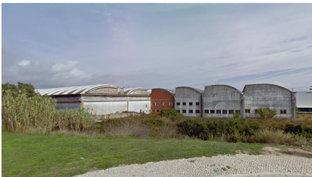
Vista a nascente, da Rua Rosa Mota, sobre o complexo industrial de armazéns
