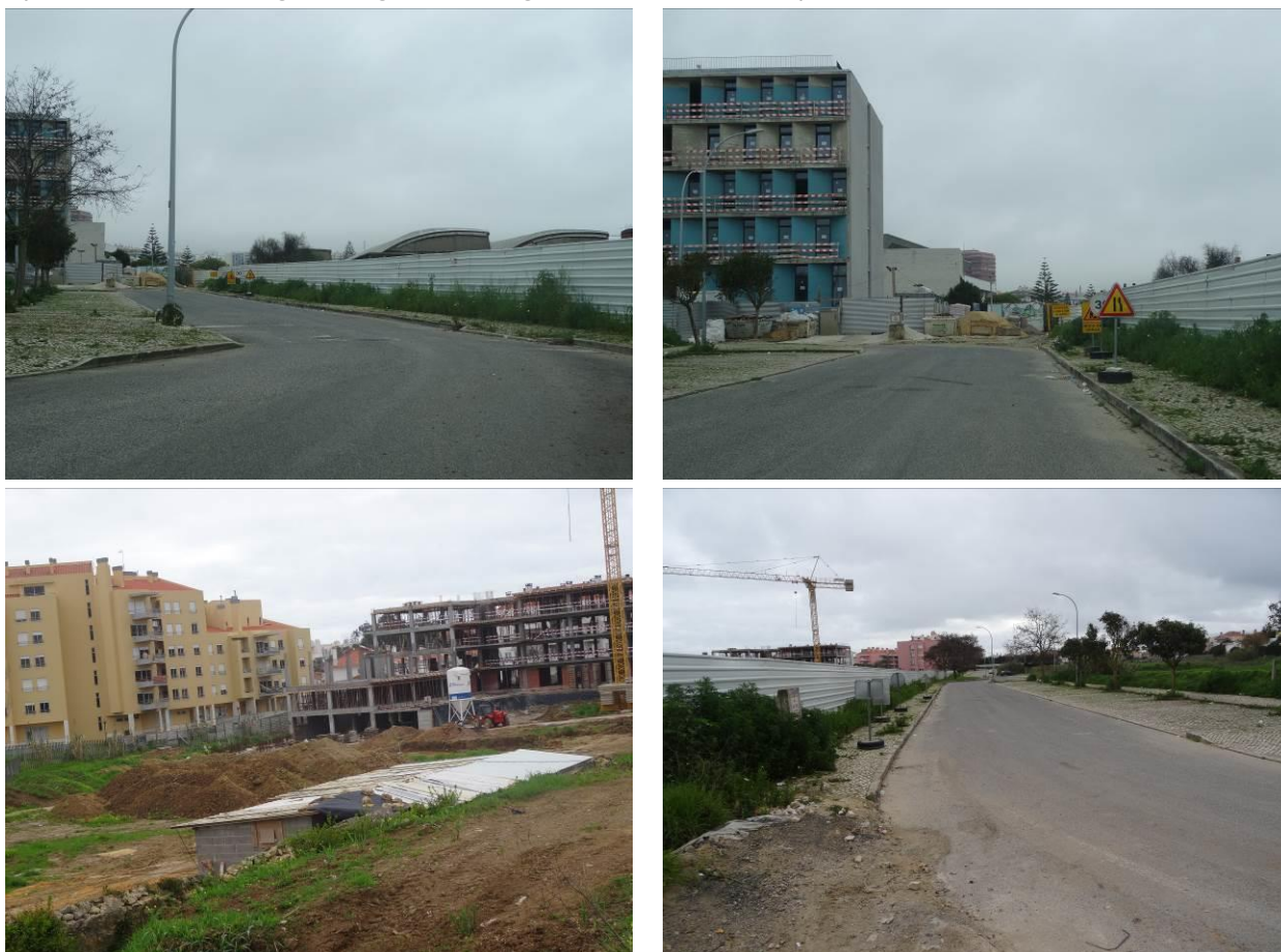
Figura 11 – Local da futura rotunda I18.
