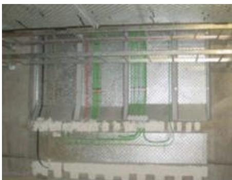
Um elemento de compartimentação é considerado corta-fogo quando é termicamente isolante, quando a elevação de temperatura não excede os 140<sup>0</sup>C em média, no espaço anexo.
