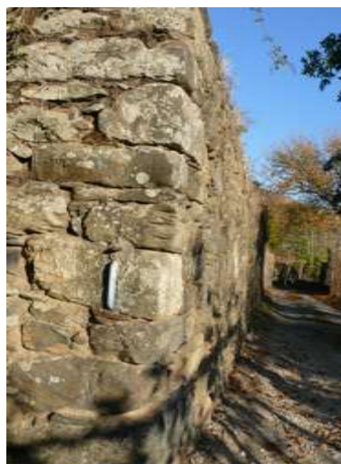
Figura 4.12.20 - Muro limítrofe de propriedade DMH2
