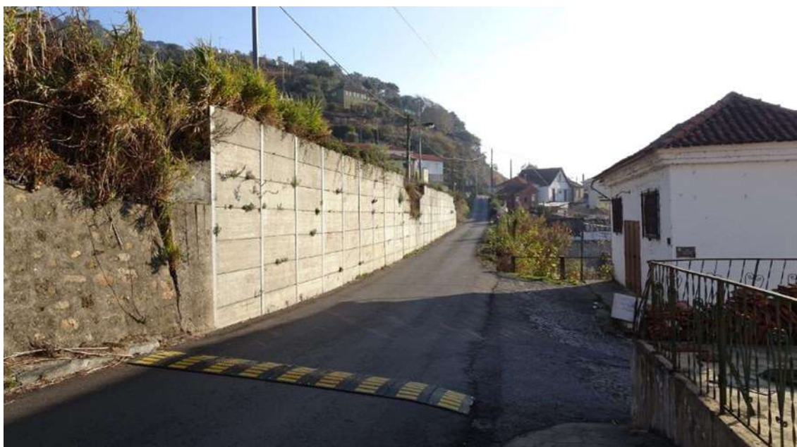
Figura 5.6.3 - Acesso de este, vindo de Peso da Régua, via passagem de nível da EN108 com a linha férrea
