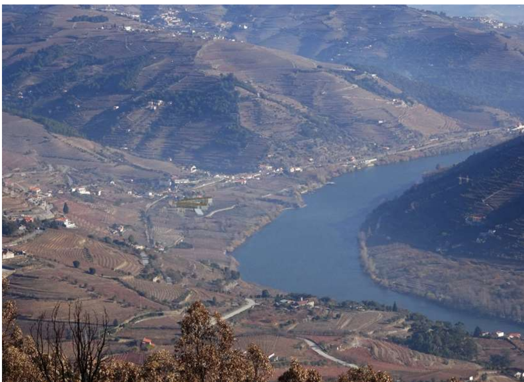
Figura 5.14.16 - Simulação da vista do projeto, a partir do Miradouro/Capela de São Silvestre
