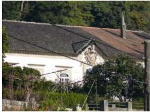
Figura 4.12.10 - Solar da Rede
