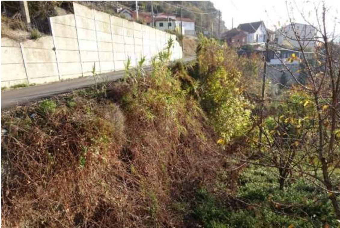
Figura 3.2.4 - Parede sul do aterro da linha férrea e via de acesso rodoviário
