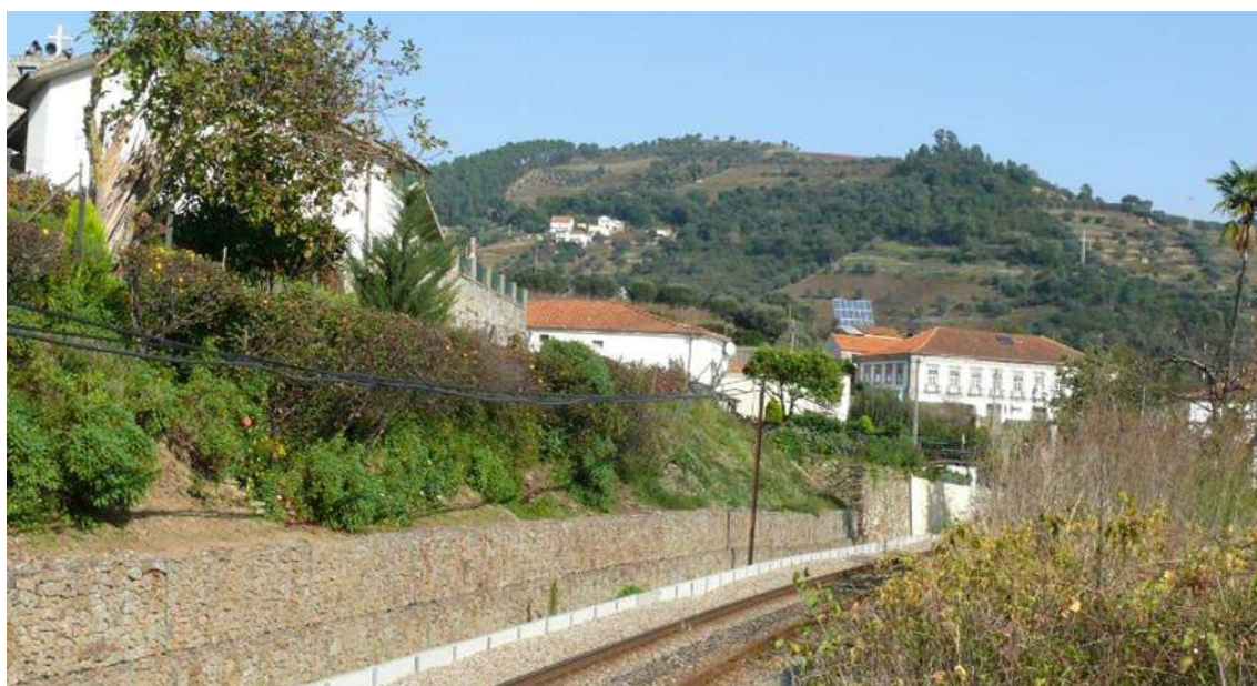
Figura 4.6.8 - Recetores sensíveis a norte da área de intervenção: igreja local e outros edifícios a norte (R06)
