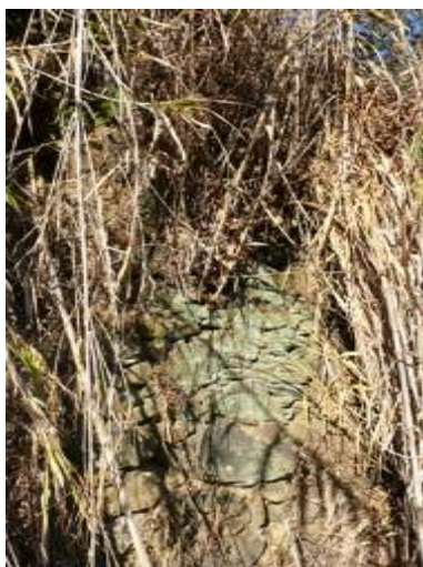
Figura 4.12.19 - Segmento de muro DMH1
