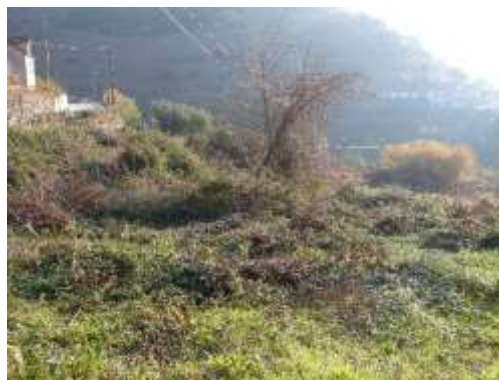
Figura 4.12.32 - Acesso à ETAR de Vila Marim (2)
