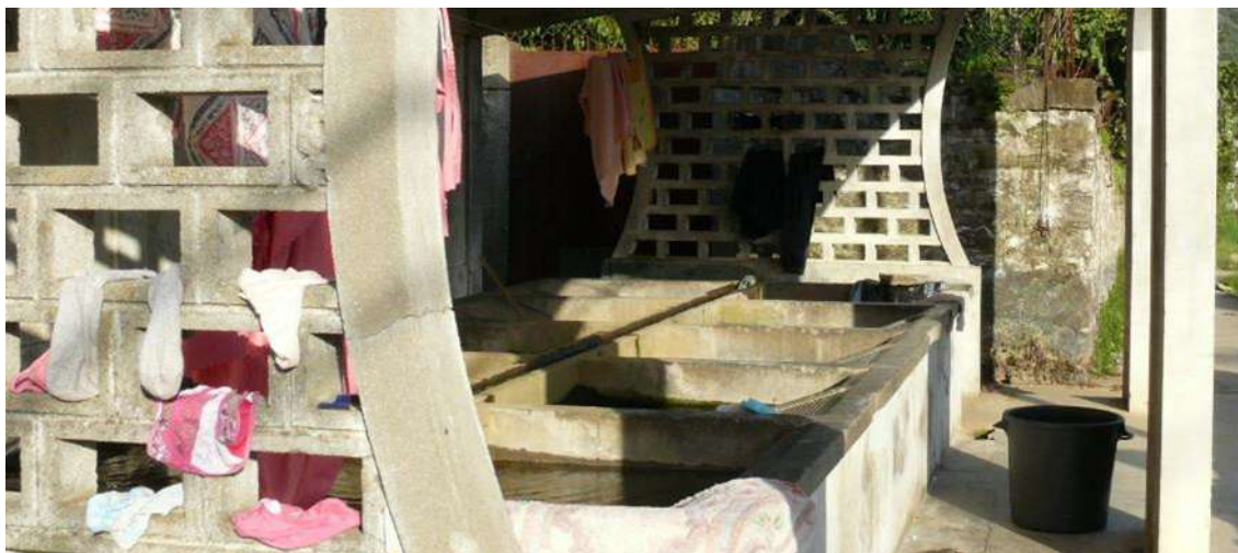
Figura 4.7.3 - Estrutura de abastecimento de uso público
