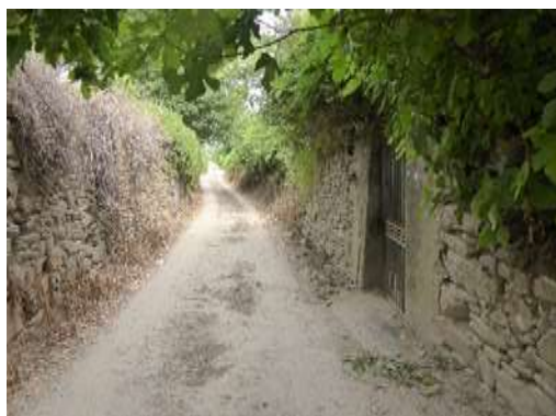
Figura 4.12.21 - Muro norte DMH3 e muro sul DMH4 do caminho de acesso
