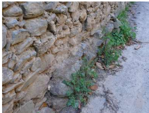
Figura 4.12.24 - Resto de muro utilizado como alicerce
