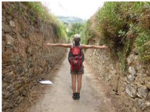
Figura 4.12.23 - Rua da Ribeira da Rede (vista sul norte)
