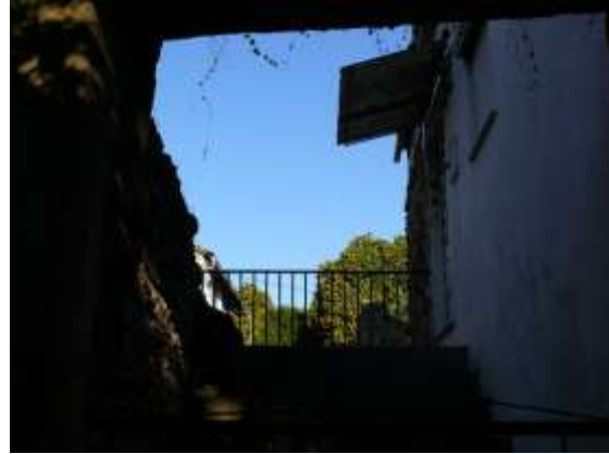
Figura 4.12.28 - Porta da capela do Santo Mártir (atualmente)
