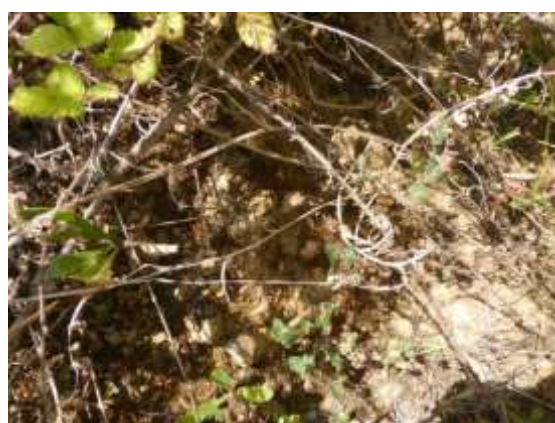
Figura 4.12.18 - Pormenor de talude existente na área de projeto
