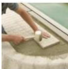
4) Colocação do pavimento envolvente
