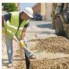
2) Enchimento entre as cubas e o fosso com gravilha
