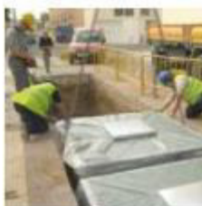
1) Colocação das cubas
