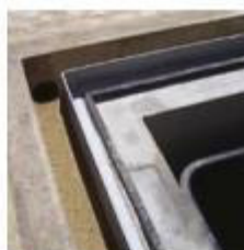
3) Colocação da caleira envolvente com tubos de escoamento
