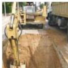
Escavação do fosso
