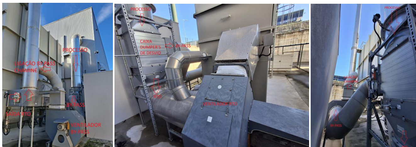
Figura 20. Registos fotográficos das condutas associadas à FF2.
