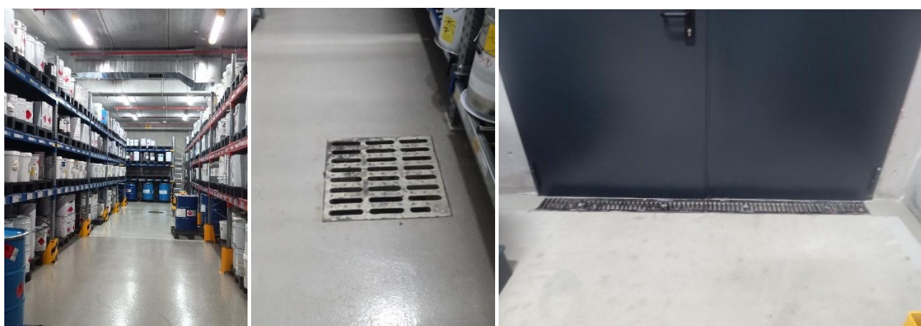
Figura 25. Armazém de produtos químicos.
