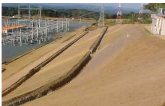
Taludes já protegidos com biomantas antierosivas
