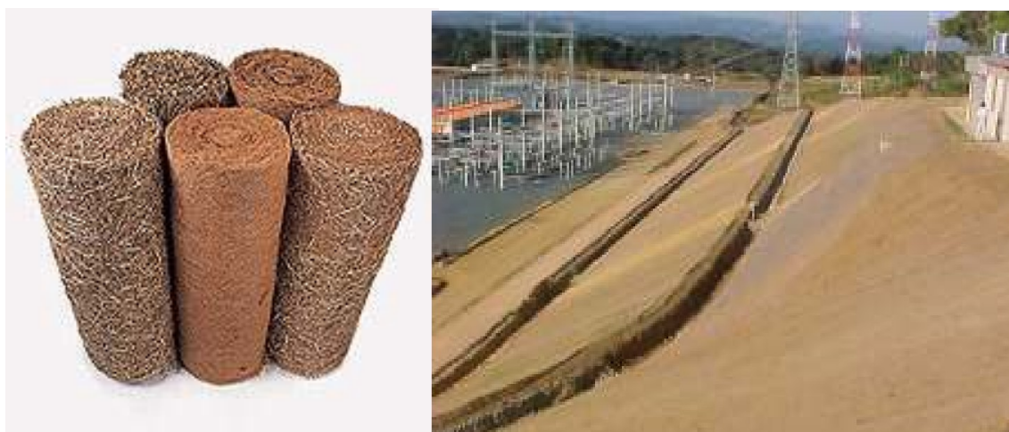
Figura 2 – Biomantas – estabilização dos taludes
