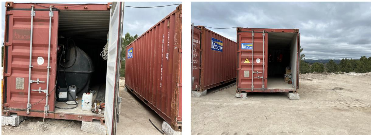
Figura 7: Contentores móveis existentes na Pedreira n.º 6519 “Quinta do Covelo” onde são armazenados os óleos usados.
