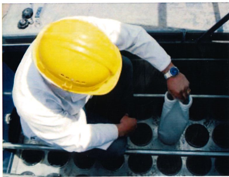
Montagem de mangas snap-ring
