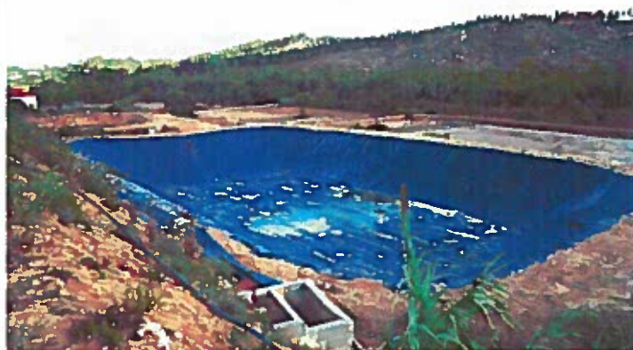
Foto 8 – 2ª Lagoa de retenção sem efluente (tela PEAD de 2 mm espessura)
