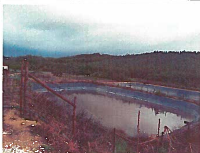
Foto 10 – 2ª e 3ª Lagoa de retenção (tela PEAD de 2 mm espessura)
