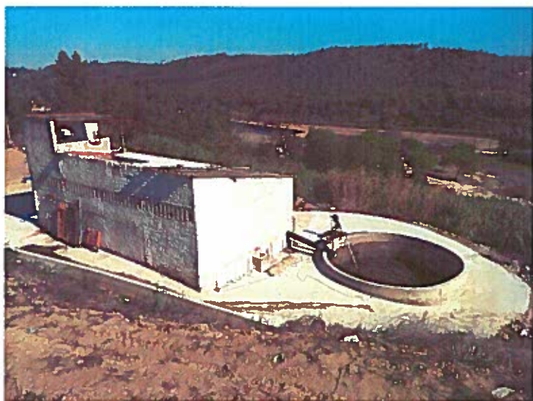
Foto 1 – Nitreira e Tanque de receção
