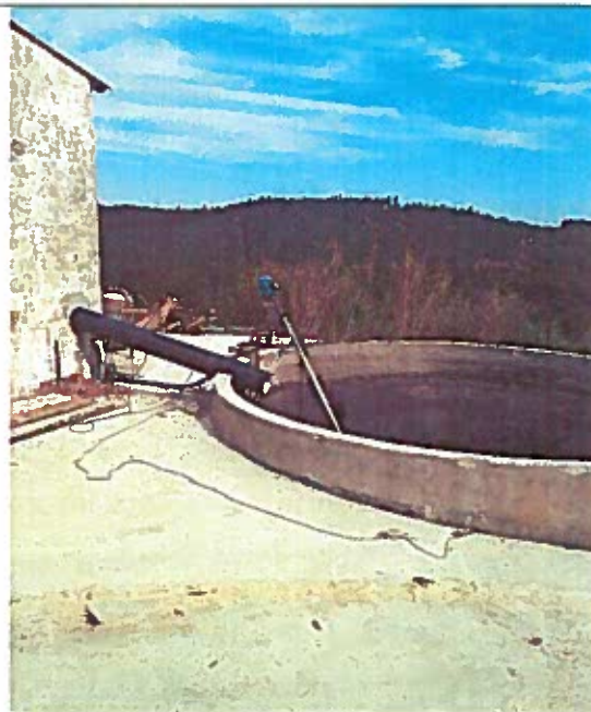
Foto 2 – Tanque receção (área envolvente impermeabilizada)
