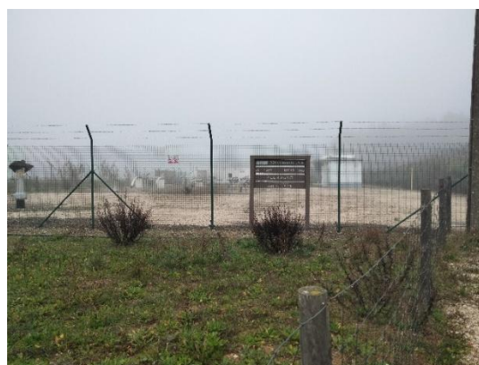
Estação de Regulação de Pressão e Medição da Abridada: GRMS 1319, onde se prevê a ligação do gasoduto
