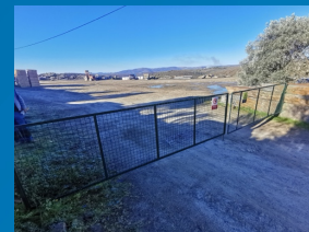
VEDAÇÃO E SINALIZAÇÃO EXISTENTE NA PEDREIRA
