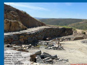
PATAMAR IMPLEMENTADO EVIDENCIANDO A IMPLEMENTAÇÃO DA MEDIDA DE SUAVIZAÇÃO E ESTABILIZAÇÃO DOS TALUDES DE INCLINAÇÃO ACENTUADA COM A CRIAÇÃO DE UM PATAMAR ELEVADO NA BASE
