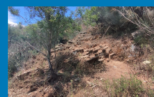
TALUDE DE TERRA E PEDRAS
