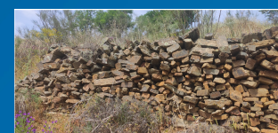
MUROS DE SOCALCO FEITOS DE PLACAS DE XISTO, EXISTENTES NA ENCOSTA MERIDIONAL
