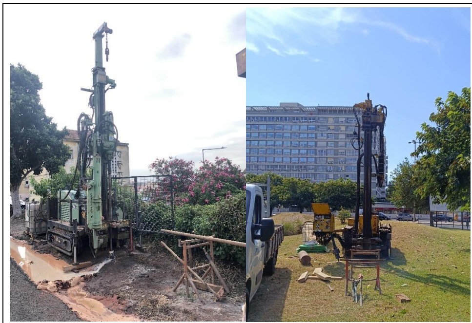
Figura 9 – Aspeto dos equipamentos de furação utilizados
