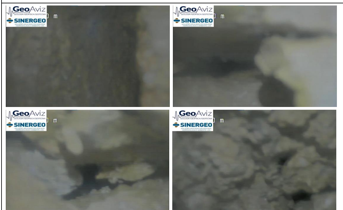
Vista lateral - das paredes do furo
