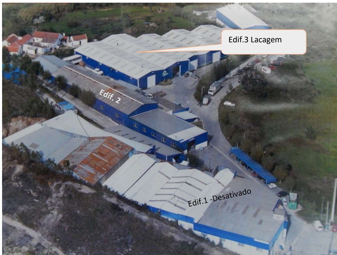
Figura 1 – Vista Atual da instalação
