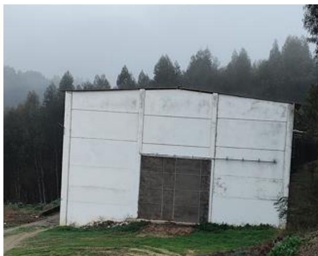
Figura 2 – Pavilhão de estrume existente
