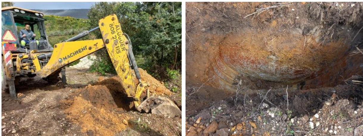
Figura 4.4 – Execução de poços de prospeção
