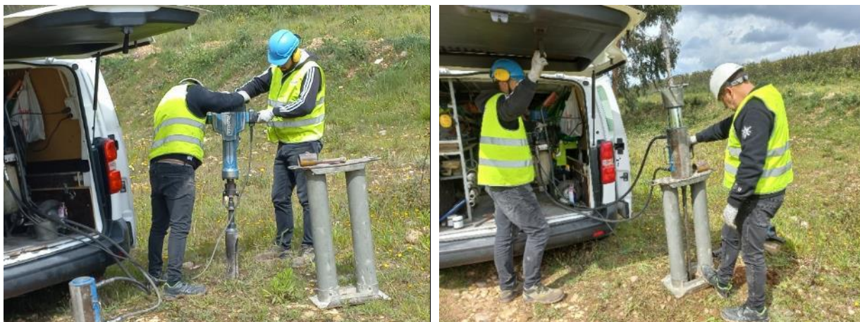
Figura 4.3 – Execução de sondagens
