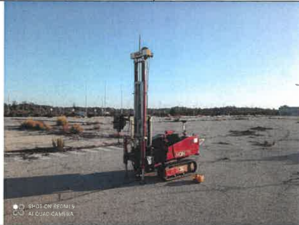
Local de realização da sondagem S9
