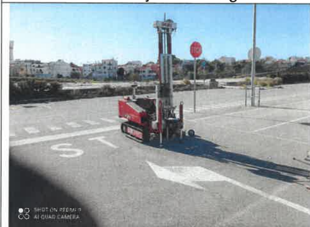
Local de realização da sondagem S3
