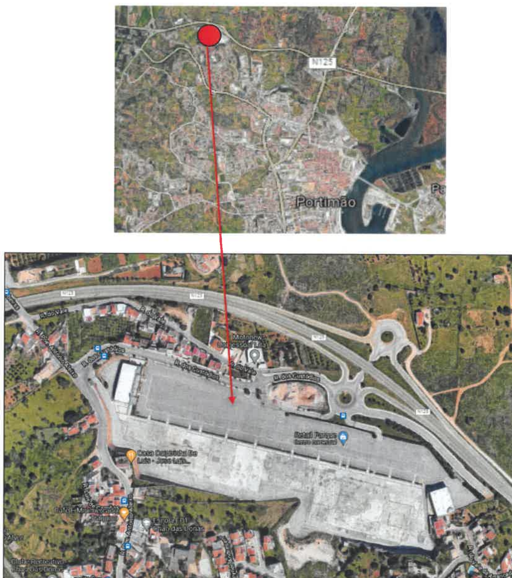
Figura 1 – Localização do terreno em estudo em Portimão onde existem os pavimentos do antigo Retail Park (imagem Google).
