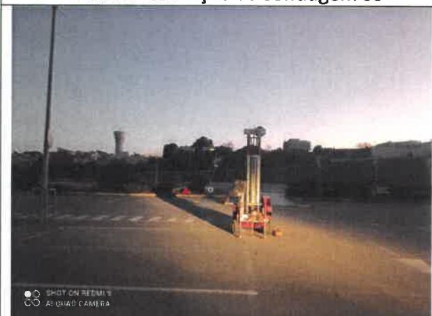
Local de realização da sondagem S5
