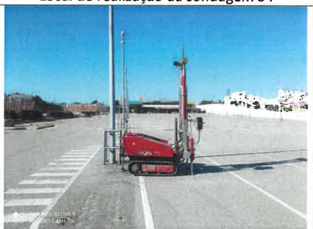
Local de realização da sondagem S6
