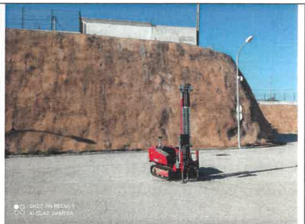
Local de realização da sondagem S8
