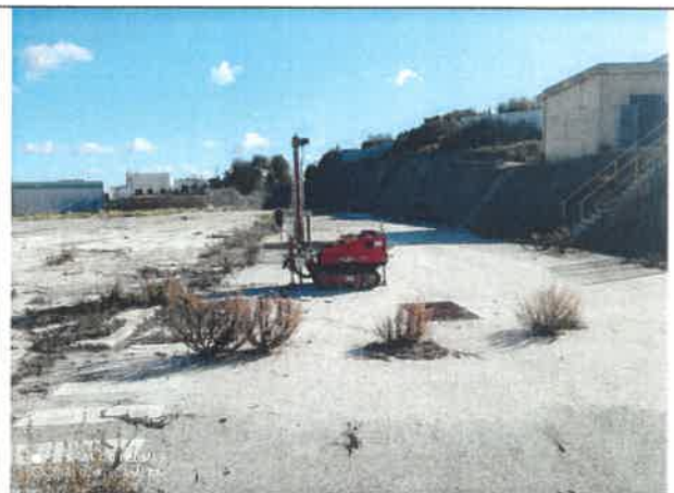
Local de realização da sondagem S2
