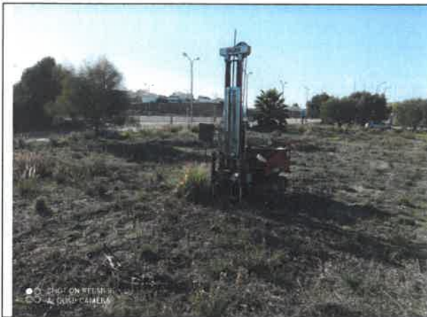
Local de realização da sondagem S7
