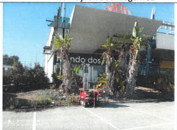
Local de realização da sondagem S4
