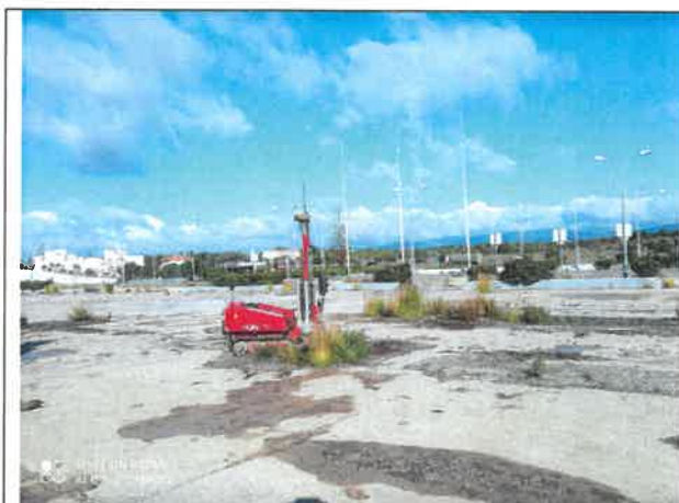
Local de realização da sondagem S1
