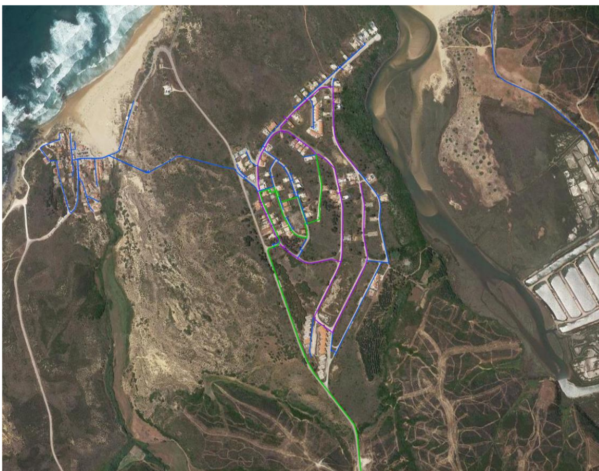
Figura 10 – Rede de Abastecimento de água para consumo humano do município de Aljezur
