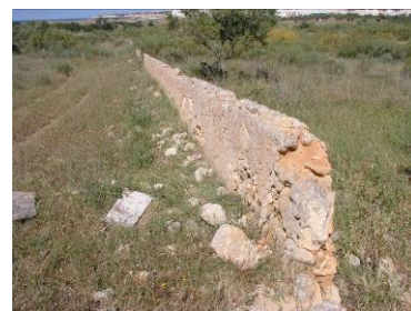
33 – Oc. 12, muro M9
