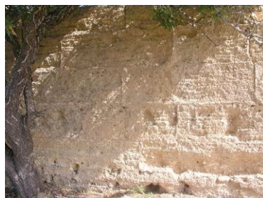
35 – Oc. 12, Fase 2 - parede externa sul
