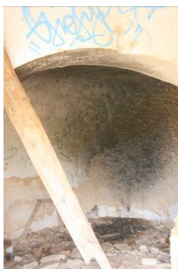
84 – Oc. 18, abóboda no piso térreo
