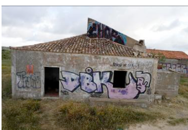
48 – Oc. 17, Fase 1 - fachada da CH
