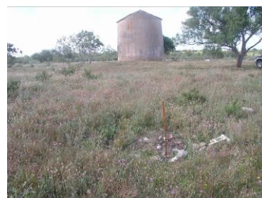
94 – Oc. 22, vista de norte
