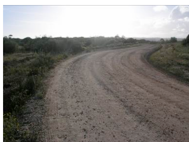
107 – Via C4, vista para o extremo oeste
