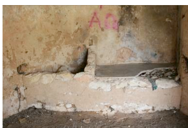
17 – Oc. 2, estruturas no piso térreo
