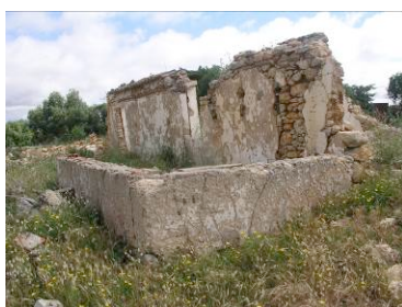
78 – Oc. 18, fachada vista de SO
