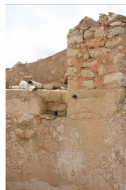
12 – Oc. 1, fechal em pedra, peças do sarilho e coluna para elevação da cobertura
