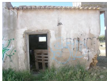
73 – Oc. 17, Fase 1 – fachada do 11
