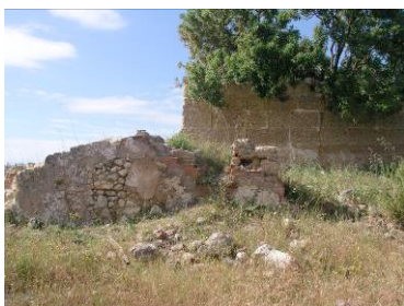
37 – Oc. 12, Fase 2 – maciço a este com janela ou porta, vista de norte
