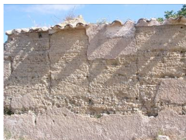
29 – Oc. 12, Fase 1 - parede externa sul
