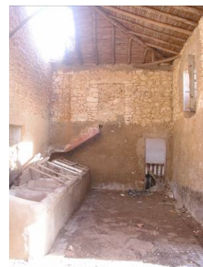
55 – Oc. 17, Fase 1 – CH, estábulo visto de sul
