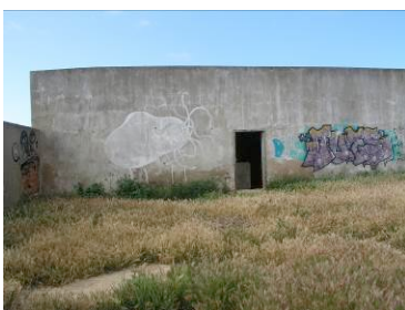
69 – Oc. 17, Fase 3 – fachada do 9
