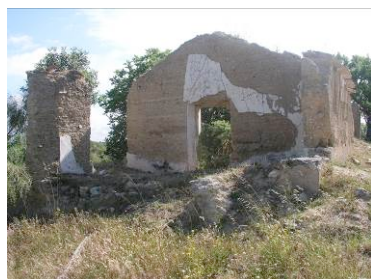
28 – Oc. 12, vista de oeste, fachada principal e parede de divisória interna
