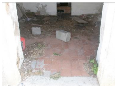
50 – Oc. 17, Fase 1 – CH, Pormenor do pavimento
