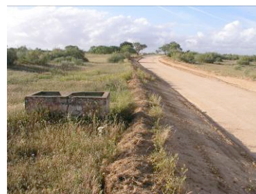
100 – Via C1c, vista para o extremo norte e tanque de preparação de sulfatos
