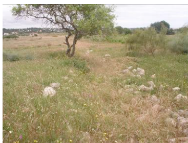
117 – Muro M8, pormenor, vista de oeste
