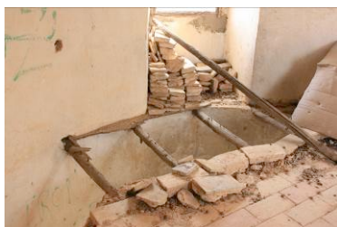
86 – Oc. 18, cobertura com alçapão da escadaria para o piso superior
