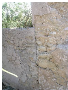
41 – Encosto entre paredes da Fase 1 e 3
