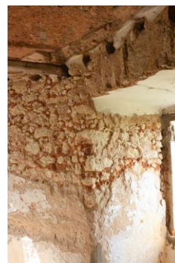
88 – Oc. 18, pormenores de fases construtivas no piso superior
