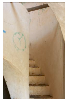
85 – Oc. 18, escadaria para piso superior
