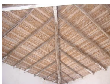
49 – Oc. 17, Fase 1 - CH, pormenor do forro interno da cobertura
