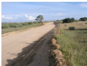
101 – Via C1c, vista para o extremo sul
