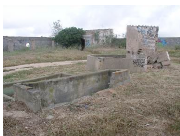
77 – Oc. 17, Fase 3 – conjunto no PE, vista de sul dos 14 e, 15
