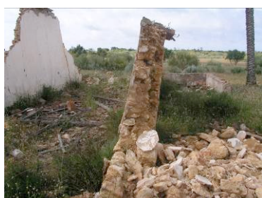
80 – Oc. 18, vista de norte
