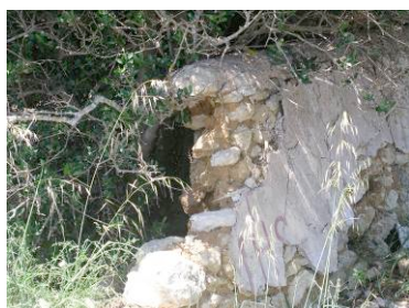
113 – Muro M4, pormenor
