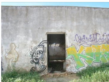
71 – Oc. 17, Fase 4 – fachada do 10
