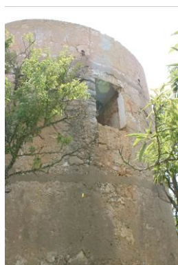
83 – Oc. 18, vista de oeste
