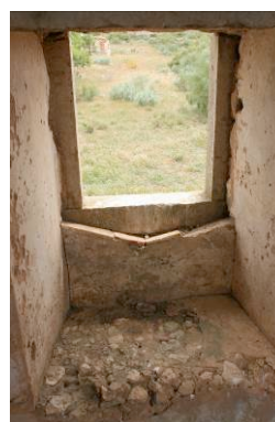
21 – Oc. 2, janela este e parapeito para drenagem de águas
