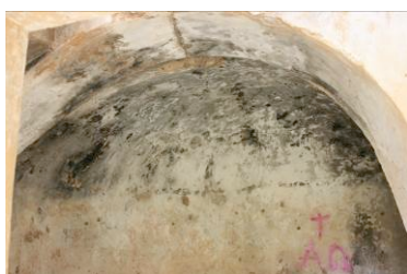
16 – Oc. 2, abóboda do piso térreo
