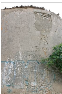
14 – Oc. 2, vista de oeste
