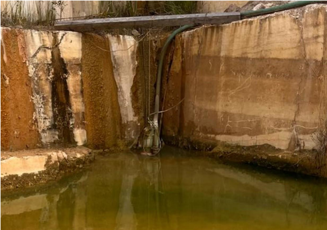
Fotografia 2: Bomba que se encontra suspensa e cuja sucção é feita de forma direta quando o nível da água sobe. O posicionamento da bomba garante que não está em contacto com os sedimentos depositados no fundo o que inviabiliza a sucção dos mesmos.
